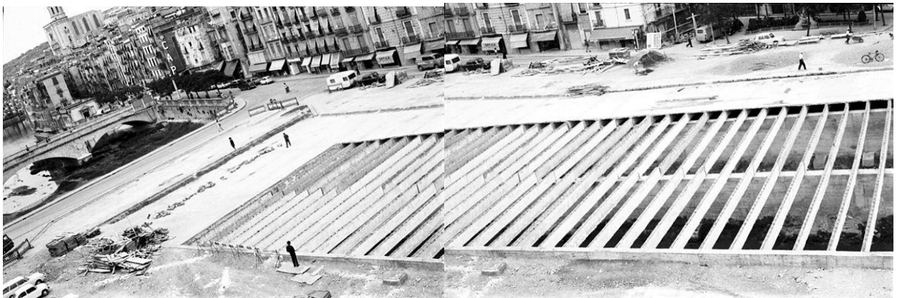
Figura 6. Col·locació de les bigues. Font: Desconegut
