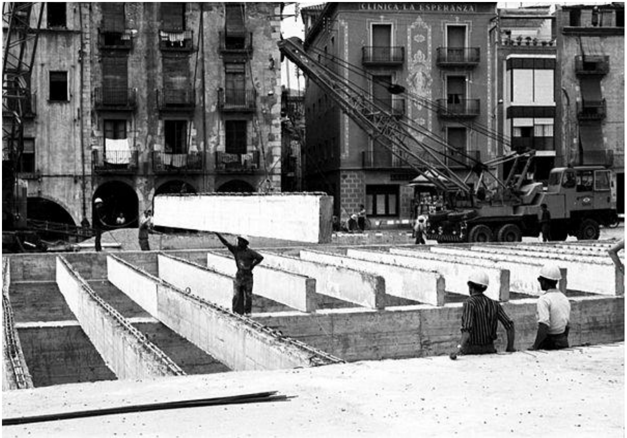
Figura 5. Col·locació de les bigues. Font: Desconegut
