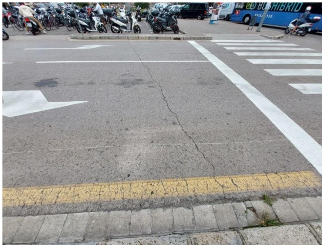
Figura 13. Esquerda en paviment asfàltic
