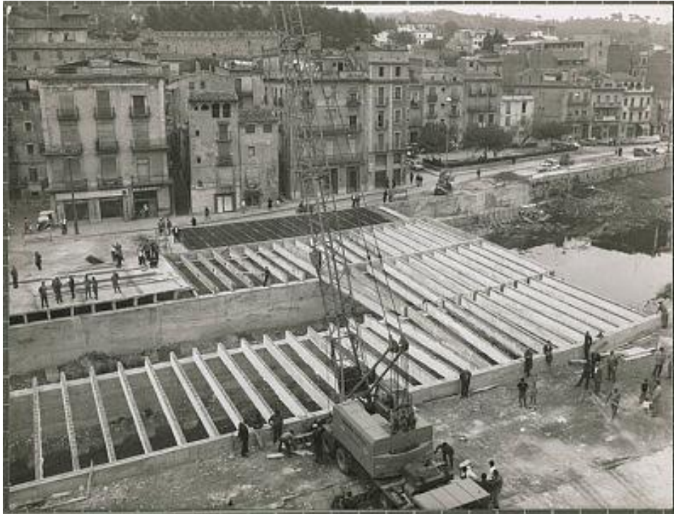
Figura 7. Col·locació de les bigues. Font: Desconegut
