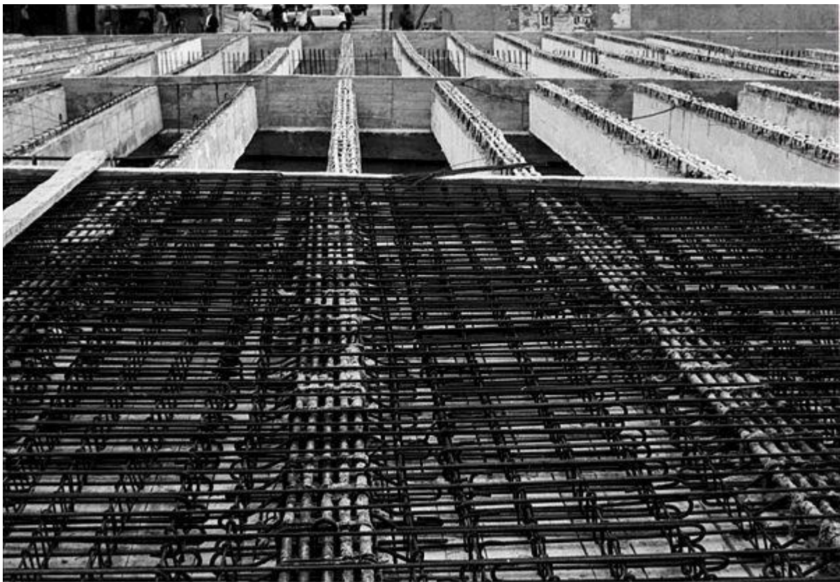
Figura 8. Ferrallat de la llosa. Font: Desconegut
