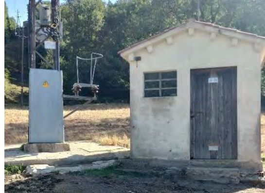
Figura 2 PK0+000 - Caseta dipòsit trencament de càrrega el Pinós
