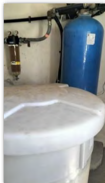
Figura 5. Interior trencament de càrrega el Pinós i filtre de calç a través de la utilització de sals
