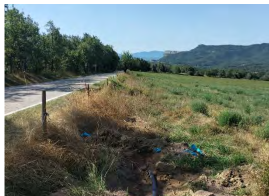
Figura 6 PK0+065 - Inici tram camp de conreu
