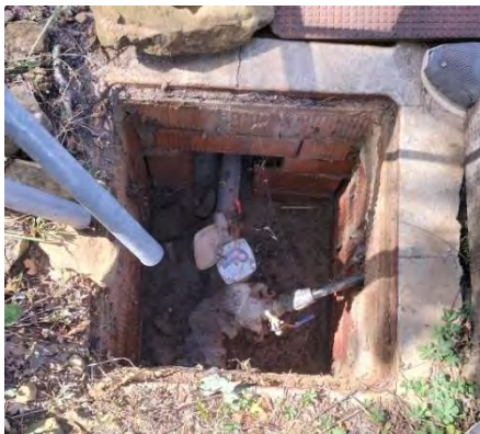
Figura 4 PK0+750 - comptador per abeurador
