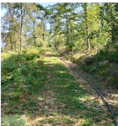
Figura 9: PK1+240 - tram camí de terres
