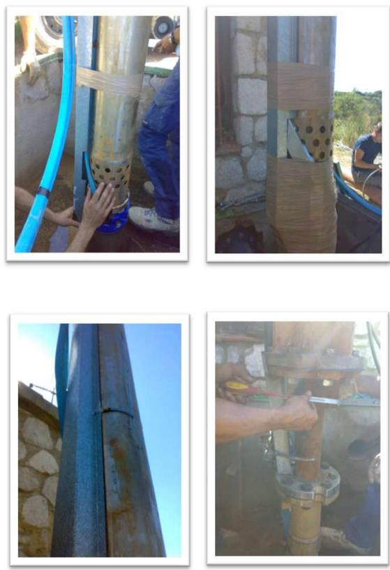
Encara aquestes proteccions, el passat mes de febrer de 2014, quan es va procedir a la desinstal·lació de l'equipament per culpa de pèrdues d'aigua a la canonada d'impulsió molt deteriorada, la instal·lació a la zona de la bomba va aparèixer de la següent manera, molt afectada, tenint en compte que en el procés d'instal·lació al 2010, no es va forçar el més mínim la introducció de l'equipament:
