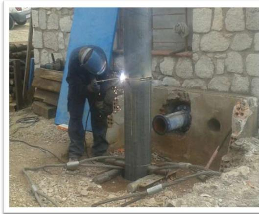
La instal·lació de la nova canonada de revestiment arriba fins als 213,5 metres de fondària. Es prova de deixar anar tot el pes de la nova canonada de revestiment amb la grua de gran tonatge, però la instal·lació no baixa, encara tenir un pes que ronda els 9.000 kgs.
