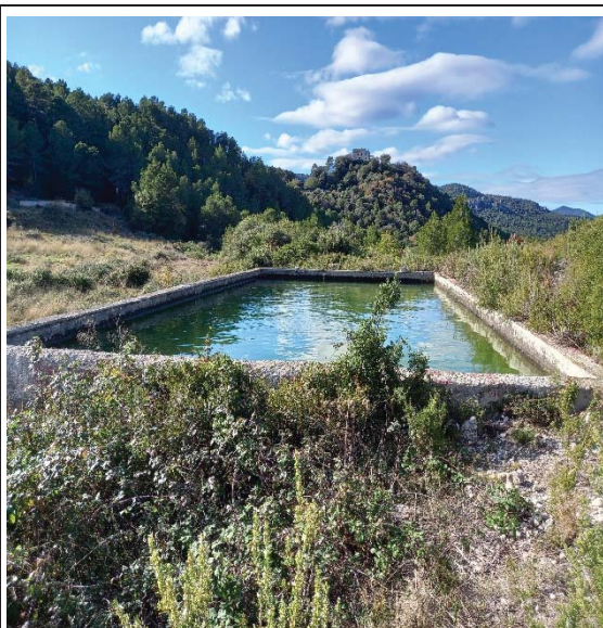
Figura 13. Estat punt d'aigua "Mas de la Torre"
