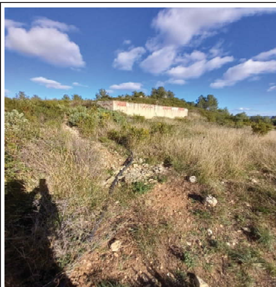
Figura 12. Estat punt d'aigua "Mas de la Torre"
