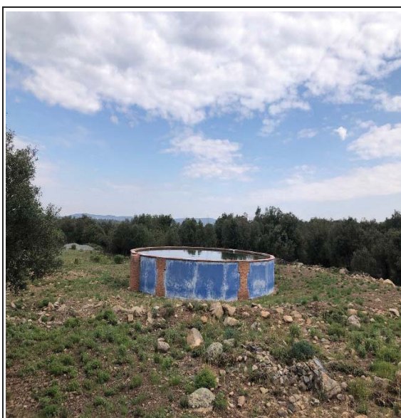
Figura 17. Estat punt d'aigua "Barranc de Castellfolit"
