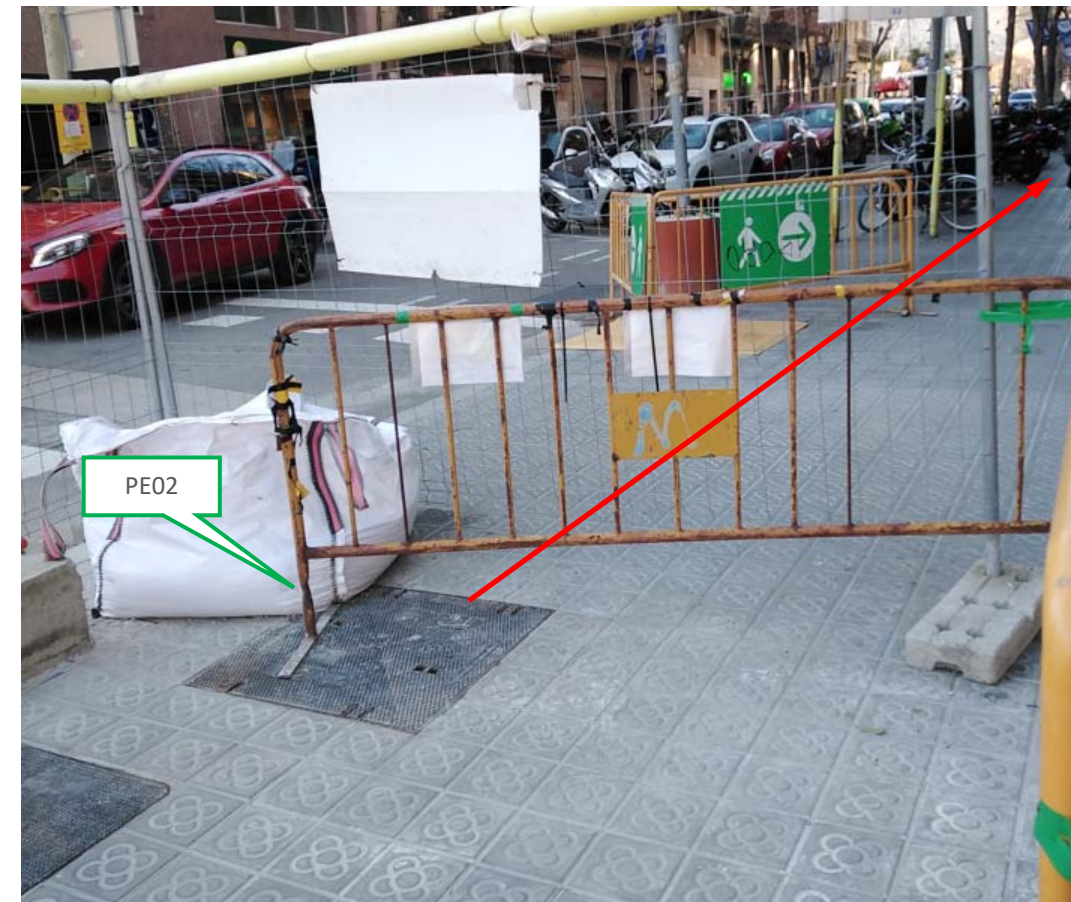
Nova canalització convencional de tipus 4c125 entre el pericó existent PE02 i el nou pericó PE03.
