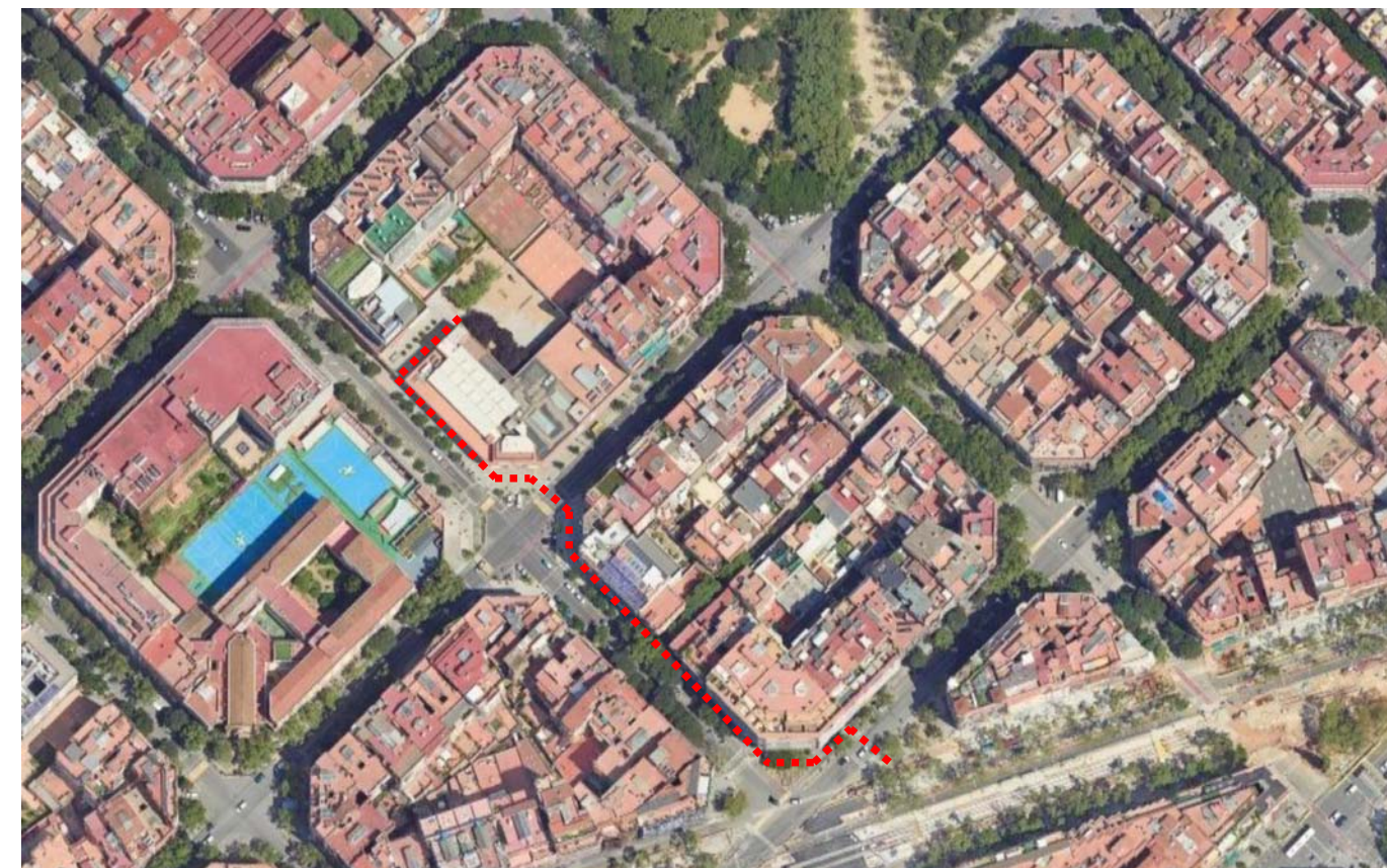
Imatge 02 – Ortofotografia de l'àmbit d'actuació de la xarxa de telecomunicacions a l'Illa Myrurgia
