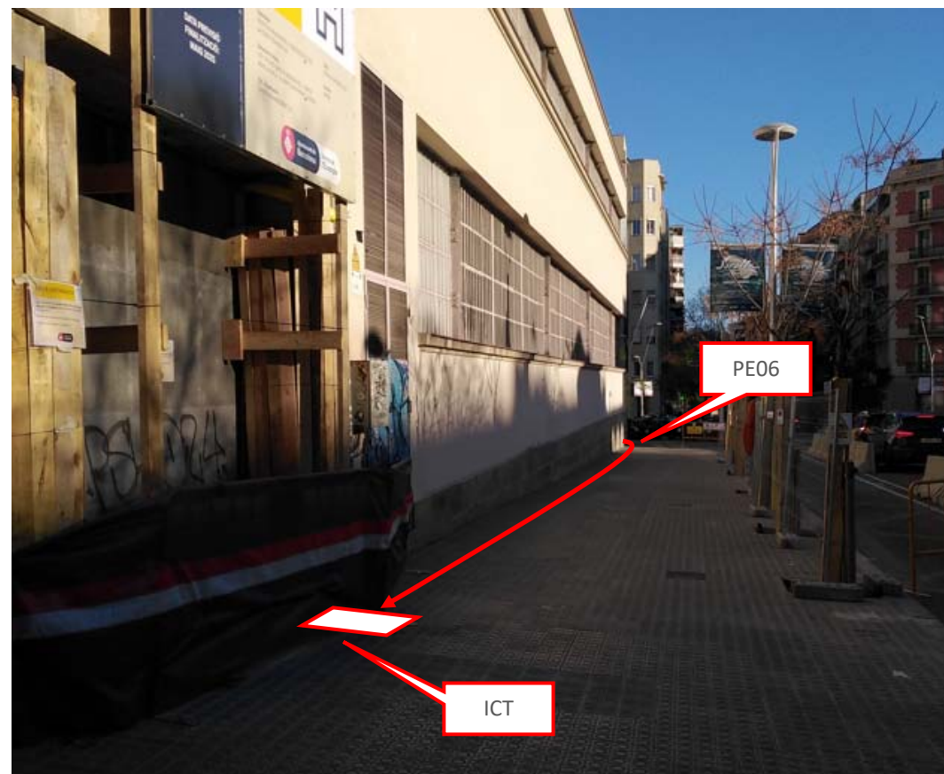
Nova canalització convencional de tipus 4c125 entre el nou pericó PE06 i el nou pericó ICT
