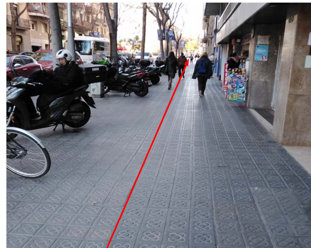
Nova canalització convencional de tipus 4c125 entre el pericó existent PE02 i el nou pericó PE03.
