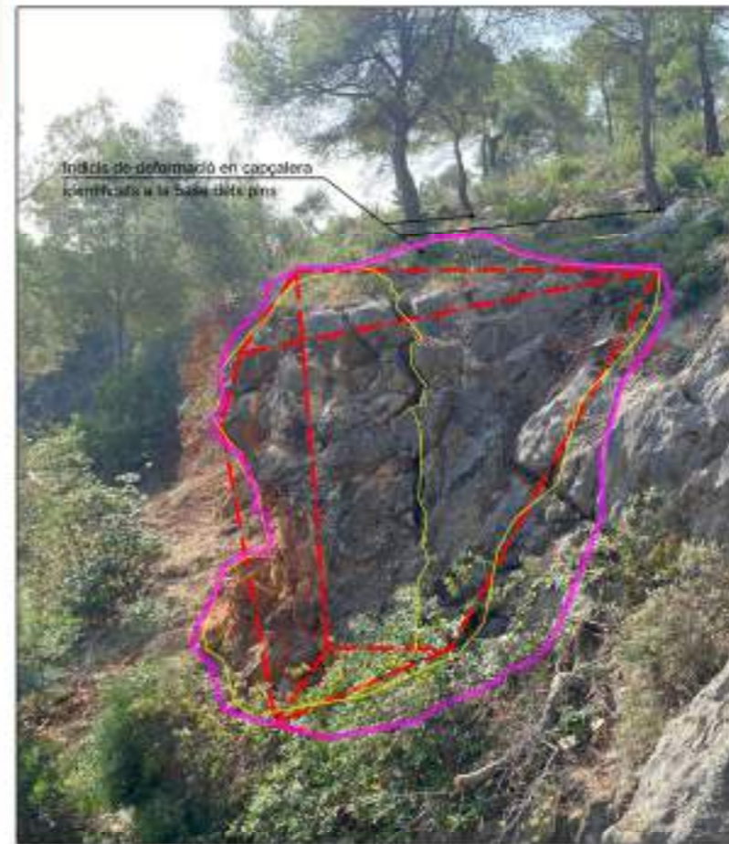
Figura 3. Vista lateral MIM-1 amb l'esquerda de tracció a favor discontinuïtats J1 i J2 (ICGC, 2022)
