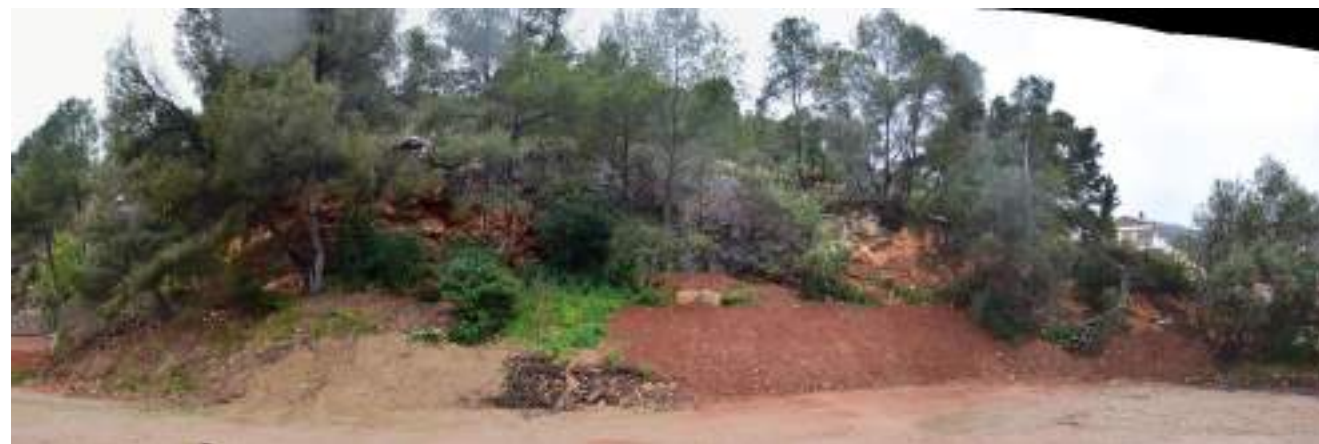
Figura 1. Aspecte general del talús, març de 2022, ICGC
