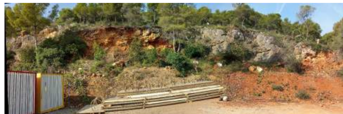
Figura 3. Aspecte actual del tram N-S del talús T1bis des del vial del carrer de Cova Fumada. Fotografia 10/2022
