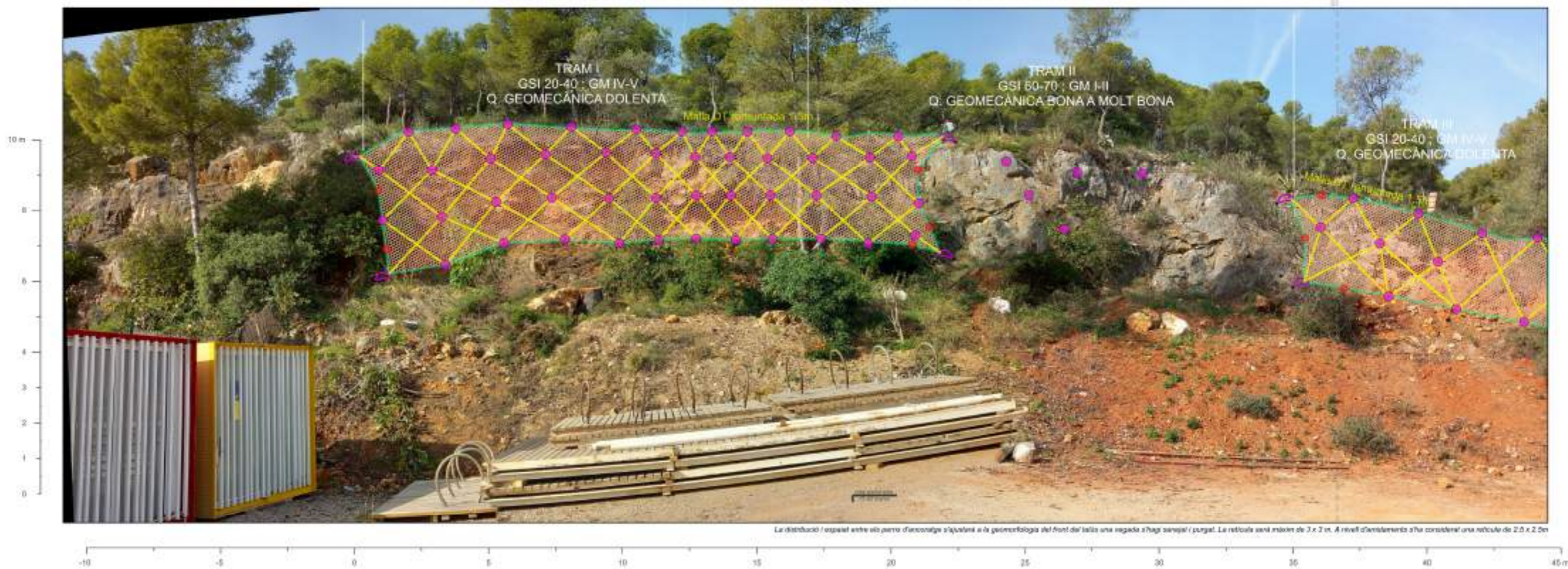
PARET FRONTAL DEL TALÚS T01bis (orientació S-N) - Trams I, II i parcialment el tram III
