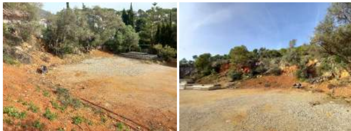
Figura 9. Aspecte del cordó de terres existent al peu del talús
