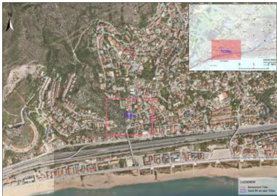
Figura 1. Situació de la zona d'estudi, amb indicació del talús urbà T01bis. Ortofoto vigent, ICGC
