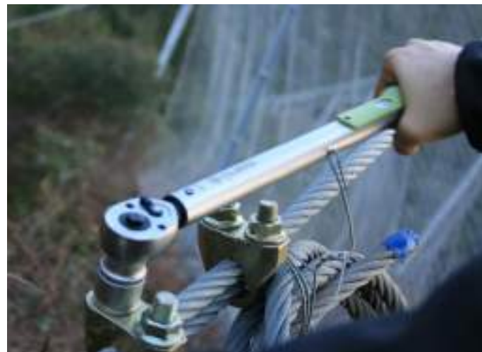
Comprovació de la força d'apretada en un premsacables amb clau dinamomètrica
