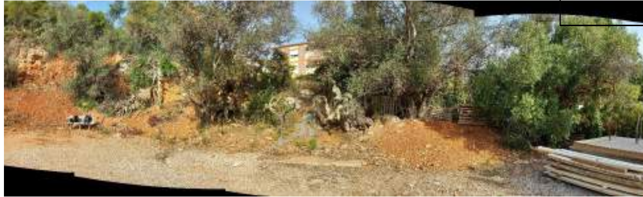
Figura 4. Aspecte actual del tram NW-NE del talús T1bis des del vial del carrer de Cova Fumada. Fotografia 10/2022
