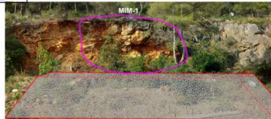
Figura 2. Delimitació del volum MIM-1 a sanejar mitjançant purga controlada (V=37m³) / prèvia construcció cortí de terres temporal de seguretat
