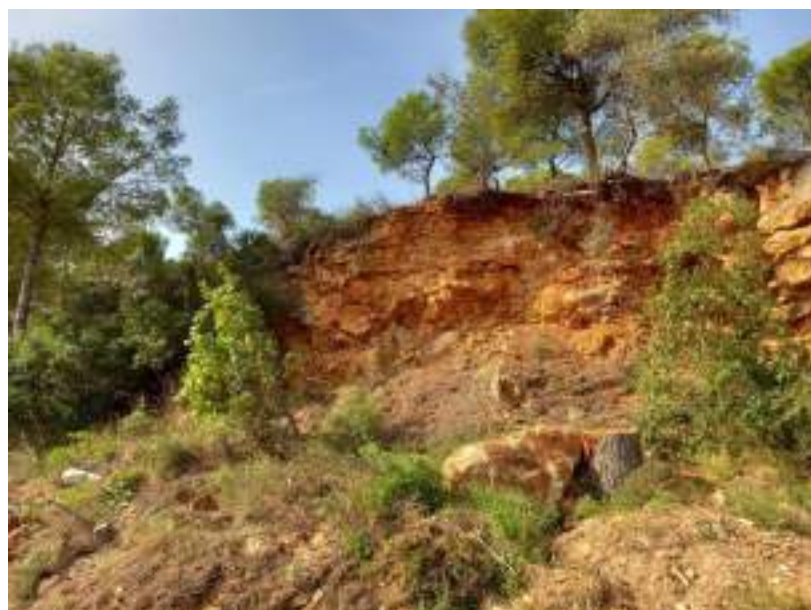
Figura 15. Aspecte de les cicatrius d'antigues esllavissades al sud del tram I
