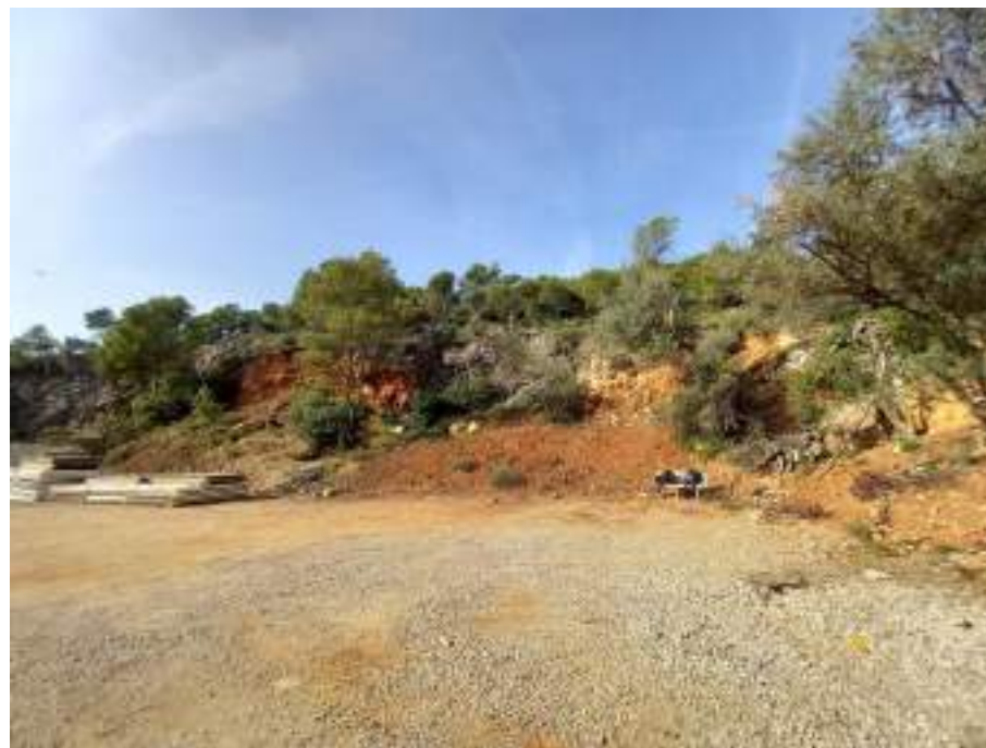
Figura 14. Aspecte del cordó de terres existent al peu del talús
