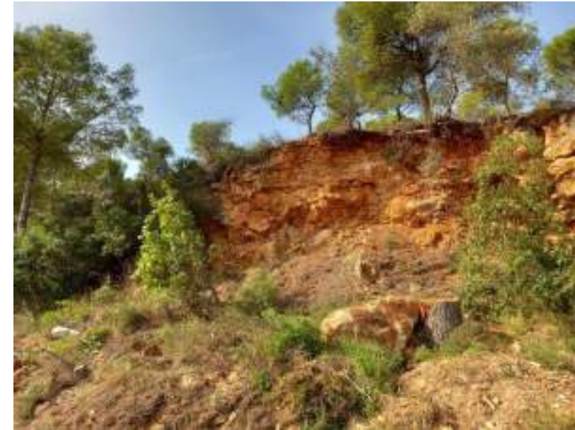
Figura 14. Aspecte de les cicatrius d'antigues esllavissades al sud del tram I
