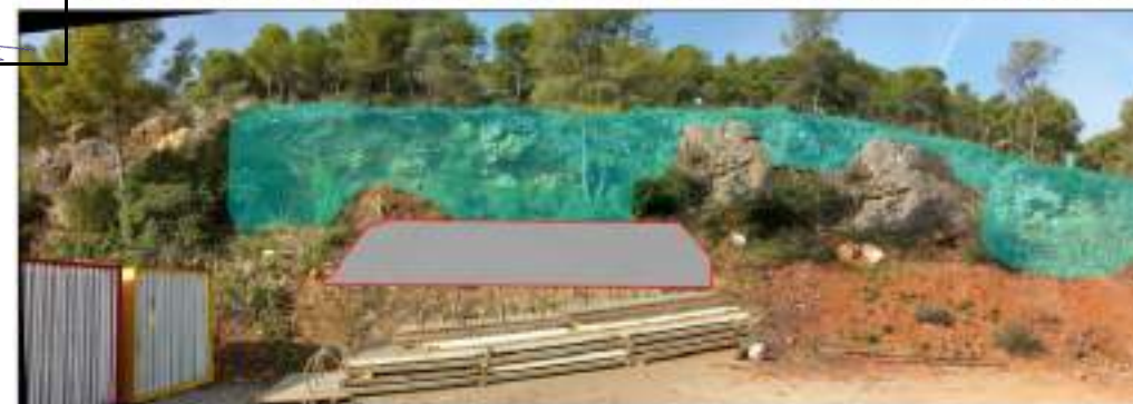
Figura 18. Vista general del cordó de terres temporal de seguretat a executar previ als treballs de purga
