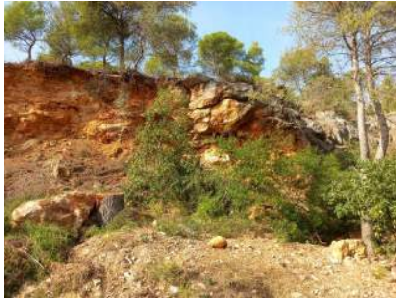
Figura 12. Massa rocallosa potencialment inestable al tram I
