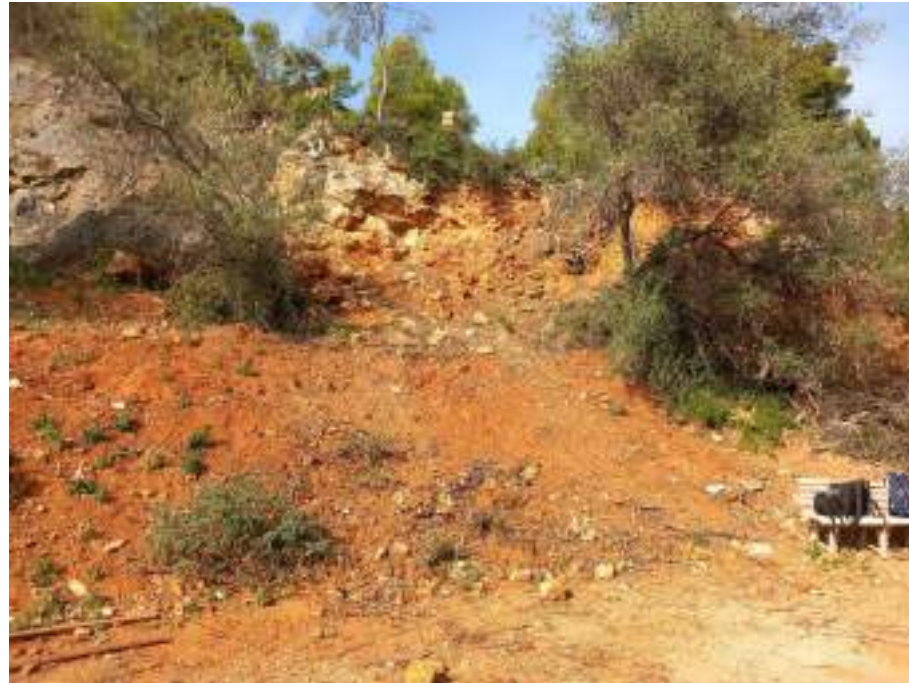
Figura 11. Massa rocallosa potencialment inestable al tram III
