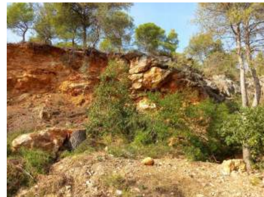
Figura 13. Massa rocallosa potencialment inestable al tram I
