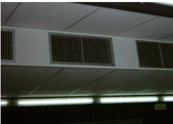
El tècnic posarà en funcionament el sistema de ventilació i comprovarà amb un anemòmetre digital, la correcta entrada d'aire a l'inici de la galeria i la correcta sortida d'aire en la zona de parabolas. Per a aquest treball s'utilitzarà una escala de telescòpica homologada per a manipular elements fins a 3,50 metres d'altura.
