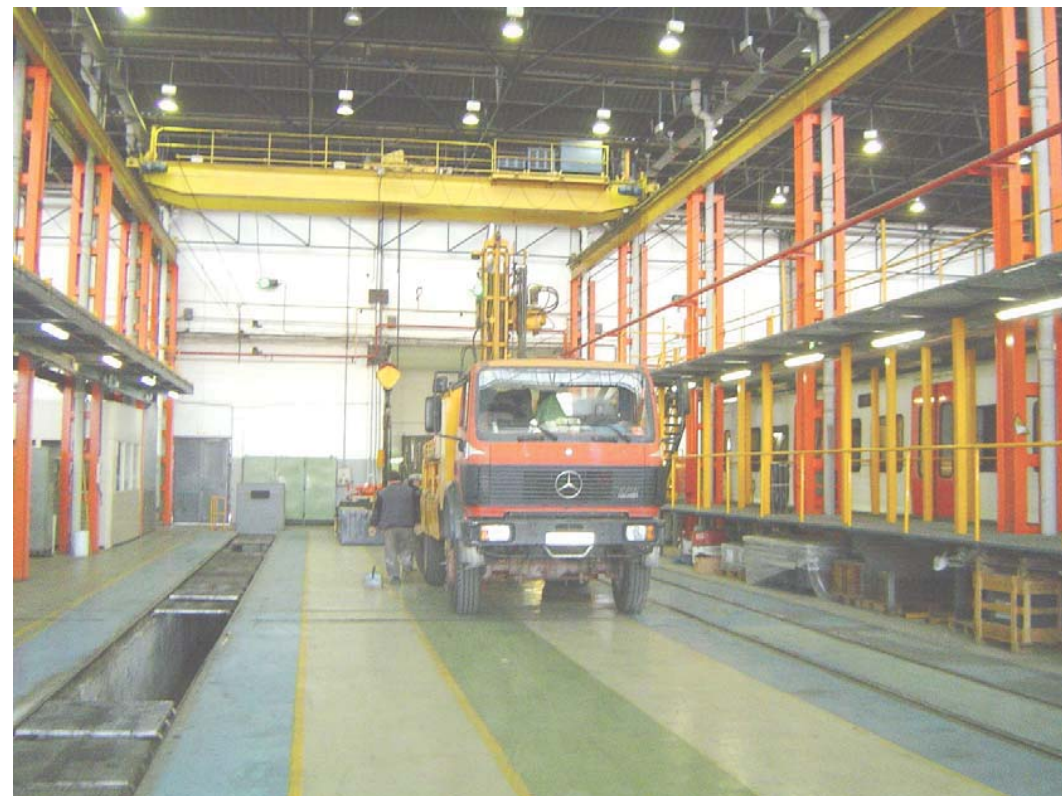
Foto 2: Realització del sondeig S-1.
