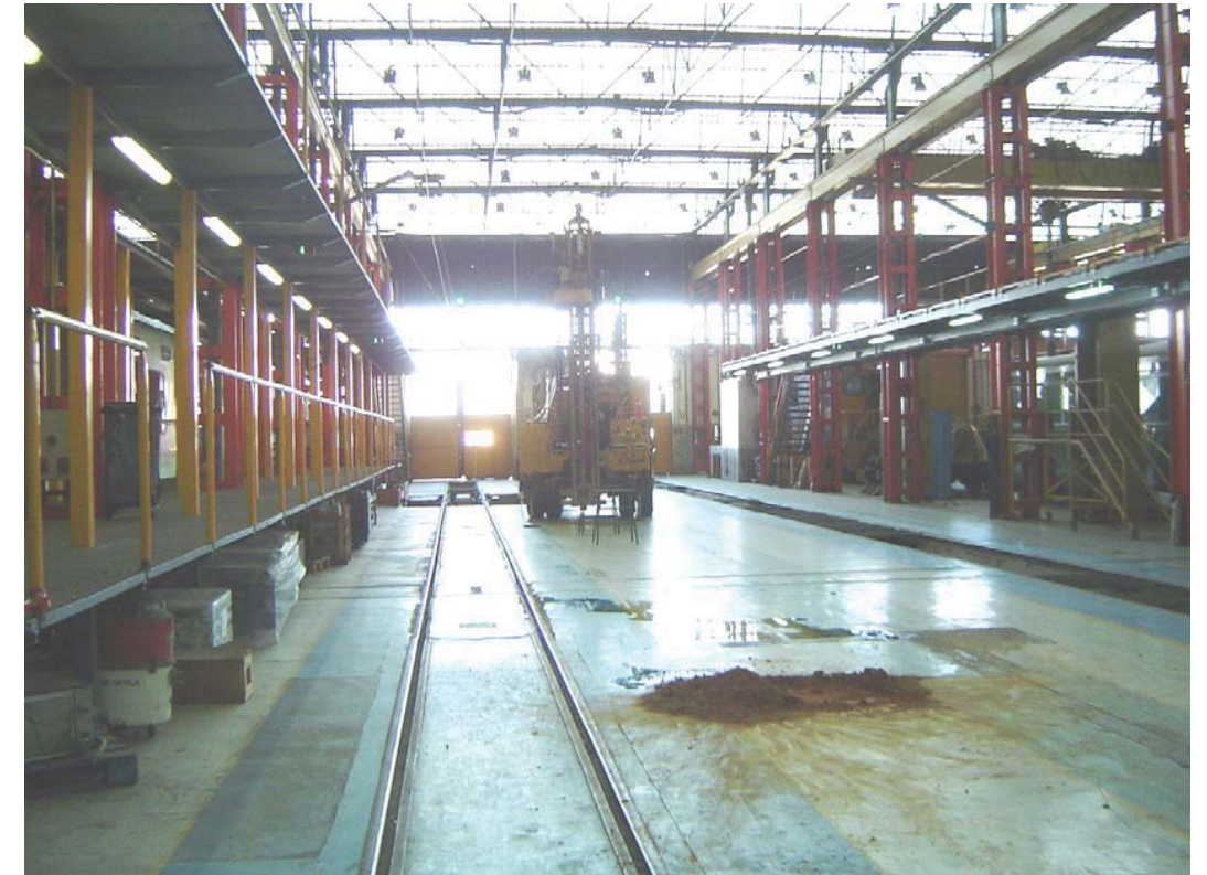
Foto 3: Màquina emplaçada al sondeig S-2.
