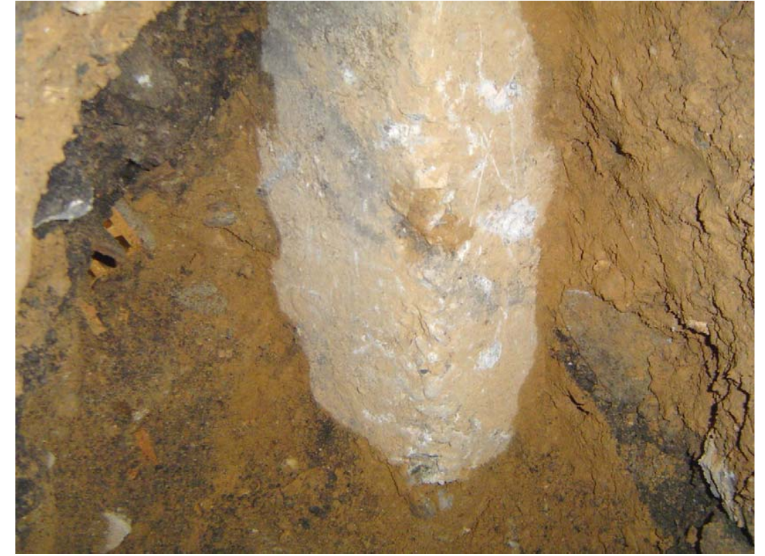
Foto 4: Cata excavada prop del sondeig S-1, per realitzar la perforació de la sabata.
