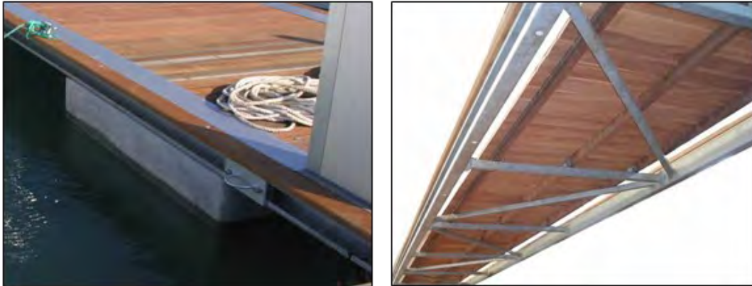
Imatge 1. Detall tipus estructura
