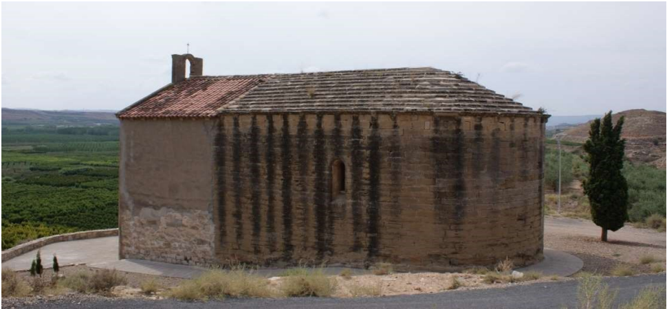
Vista de la façana de sol ixent l'ermita de Sant Joan de Carratalà. S'observa com l'obra romànica queda mutilada per la incorporació al segle XVIII d'una estructura arquitectònica nova realitzada a partir de materials reaprofitats de la romànica. (foto: Ramon Solé).
