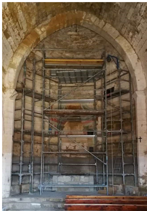
Vista de l'absis durant els treballs de Conservació i Restauració (foto: Ramon Solé).
