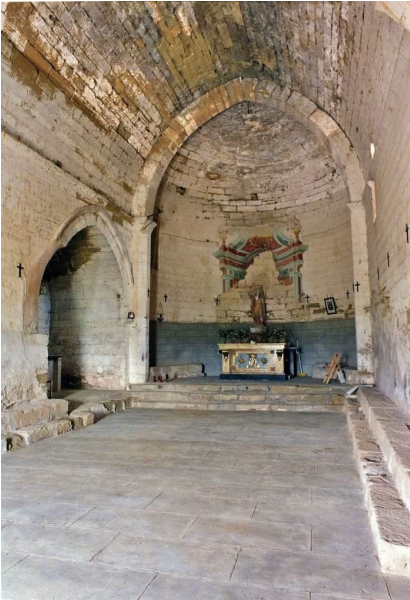
Vista de l'interior de l'ermita de Sant Joan de Carratalà abans de l'inici de la restauració de l'àmbit de l'absis (imatge d'arxiu)
