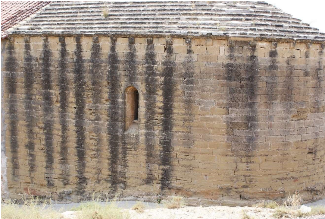
Façana orientada a sol ixent. Pàtina d'algues en els indrets on s'ocasionen escolaments de l'aigua pluvial. Aquests assentaments d'algues i molses també afecten les mènsules i cornisa de la coberta (foto: Ramon Solé).
