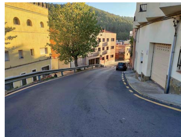
FOTO 1. Vista de la coronación C/Rodera.
