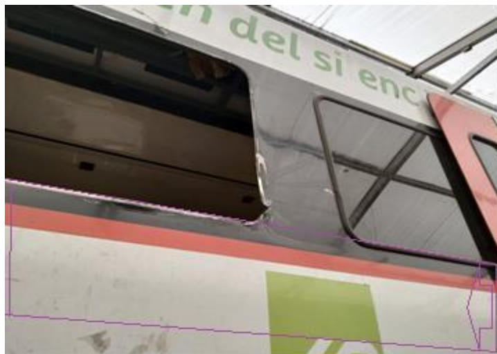
Figura 14: Lateral esquerra entre cabina y primera porta de passatge.
