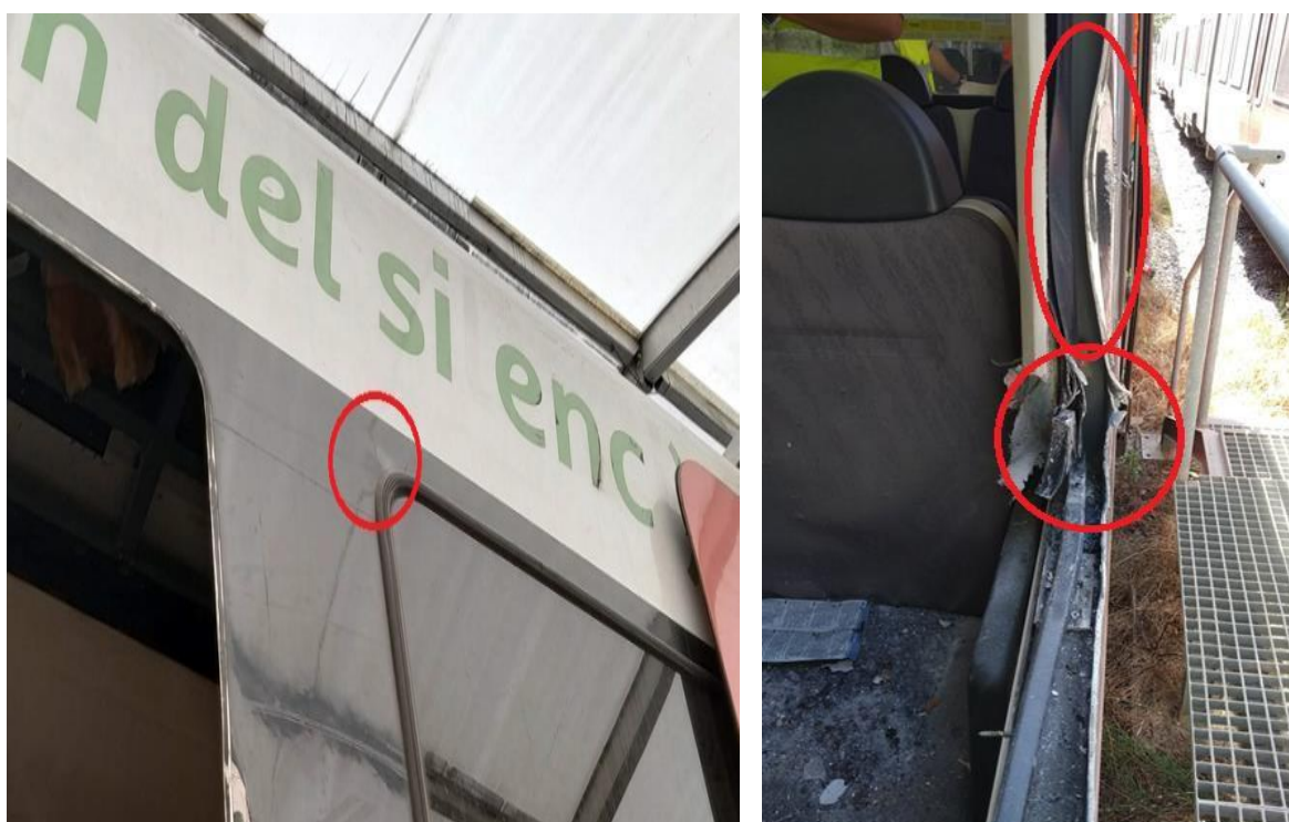
Figura 15: Montant entre finestres
