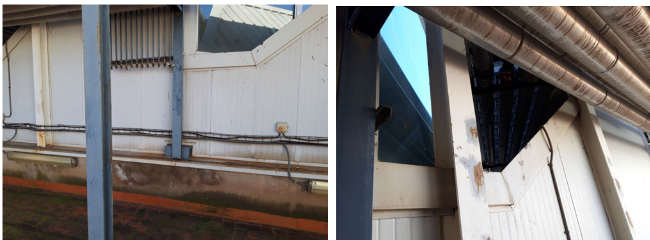
Paret vertical d'accés a les finestres i a la coberta dentada, amb pas de canonades de Clima.
