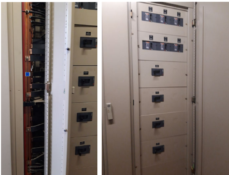
Embarrat i Quadre General de Clima a connectar la FV.
