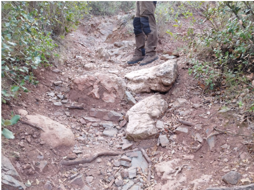
Figura 15: Tram escorrenat del camí.
