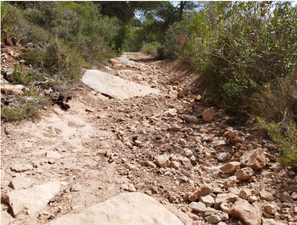
Figura 3: Tram amb escòrrecs i aflorament de roca mare.
