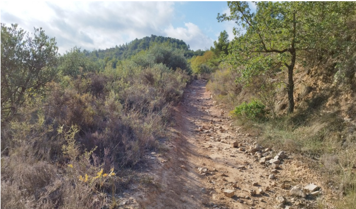
Figura 7: Tram baix, on el camí s'ha anat excavant per l'erosió i ha anat reduint l'amplada original, que permetia el pas de carros.
