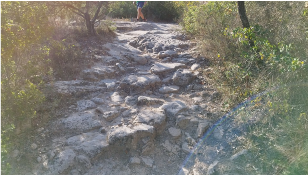
Figura 11: Punt on el camí arriba a una llisera de roca, des d'on es pot desviar l'escorrentia al marge, i on s'ha de consolidar l'empedrat.
