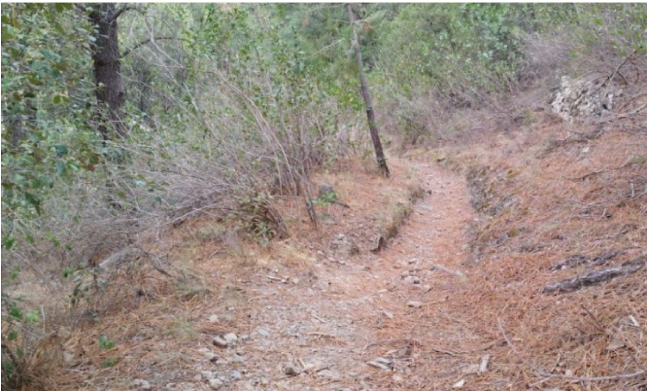
Figura 18: Tram escorrentat i encaixat del camí que condueix tota l'aigua.
