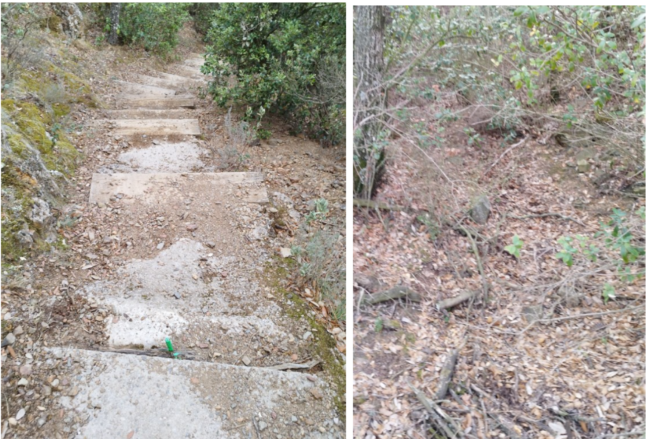
Figura 18: Tram escorrentat i encaixat del camí que condueix tota l'aigua.
