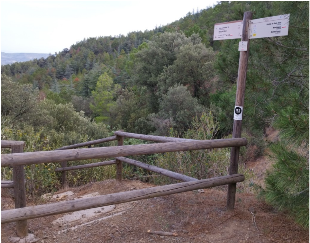
Figura 32: Baranes d'accés a les escales de formigó, que s'han de reubicar per reconduir els excursionistes al camí recuperat.
