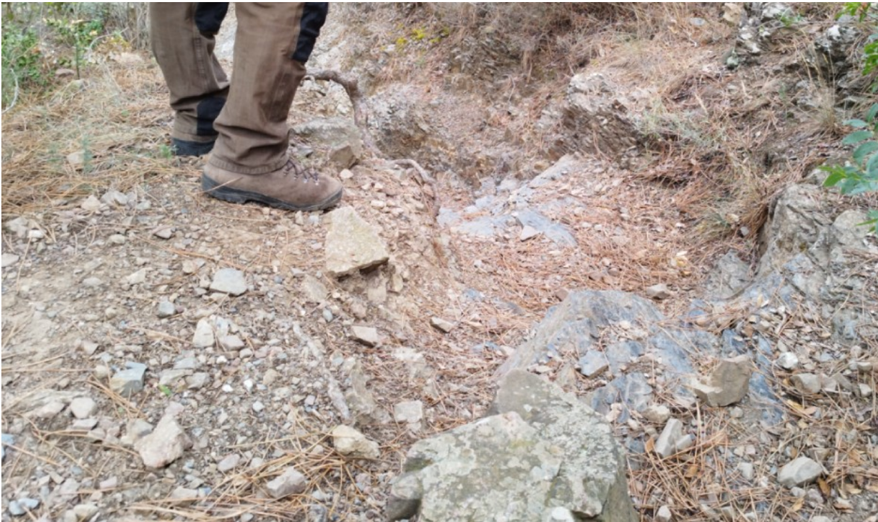
Figura 19: Tram escorrentat i encaixat del camí que es pot evitar recuperant un antic retomb del camí històric.
