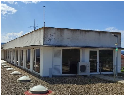
Façana posterior (Planta segona administració, dreta i esquerra)
