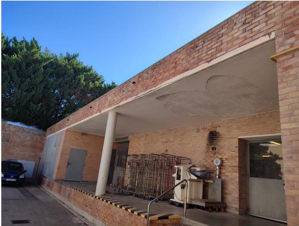
Dentell i sostre cobert del moll de càrrega i descàrrega de Bugaderia i Magatzem
