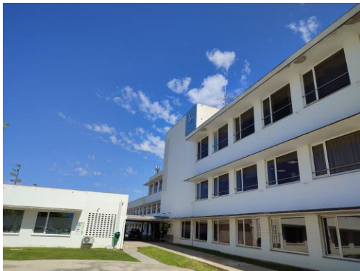
Façana principal torre rellotge
