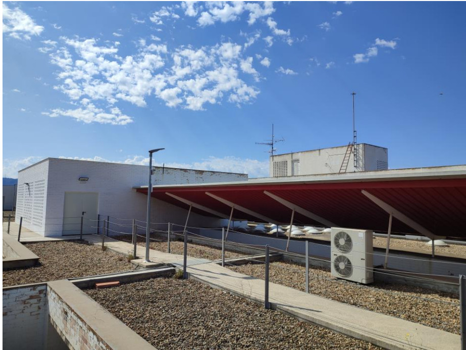
Façana posterior (Detall torre rellotge amb antenes i paral·lamps)
