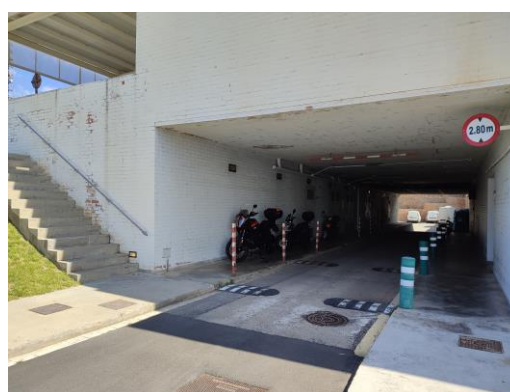
Tunel de serveis
