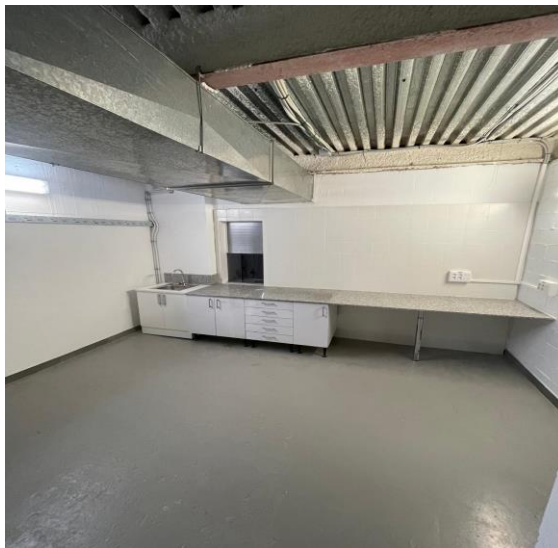
sala ERA's "zona neta"
