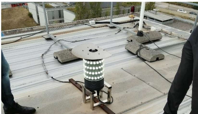
Figura 12. Exemple llum de far d'heliport.
