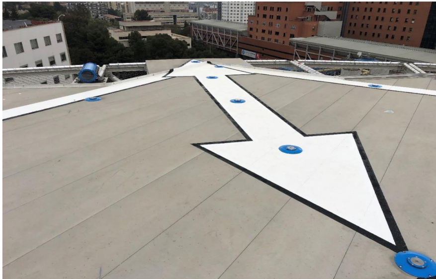
Figura 6. Sistema de guia d'alineació de la trajectòria de vol (senyal i sistema d'il·luminació).
