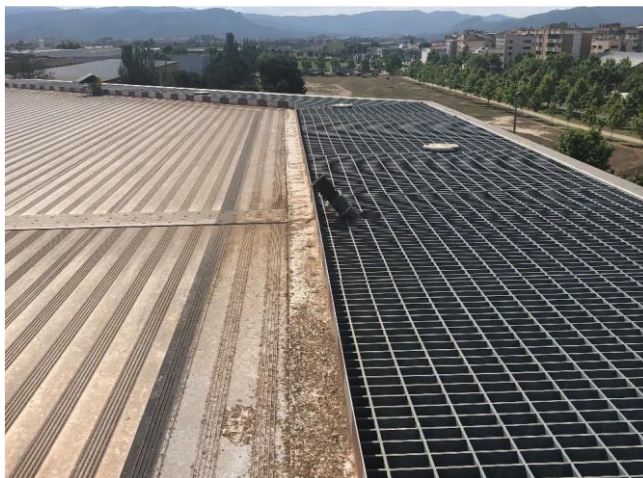
Figura 8. Monitor d'extinció d'incendi de l'heliport
