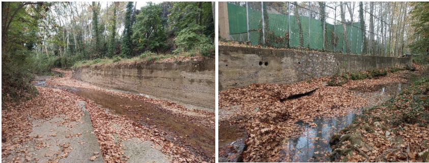
Figura 29. Imatges de les estructures a retirar a la zona del gual de Can Costa
