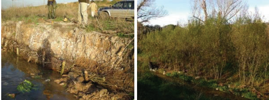
Figura 3 Imatges d'una feixina viva instal·lada per Naturalea
