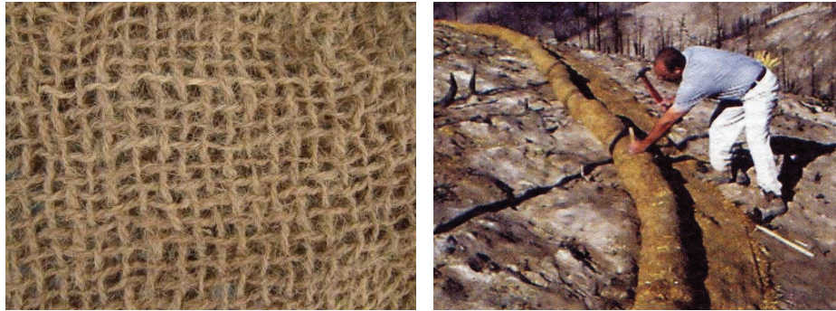
Figura 17 Imatge de detall de la fibra de coco que constitueix els rolls d'escorrentiu (esquerre) i col·locació d'aquests (dreta).
