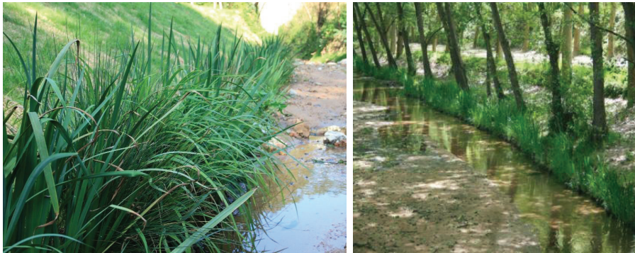
Figura 12 Exemples de rolls vegetalitzats instal·lats
