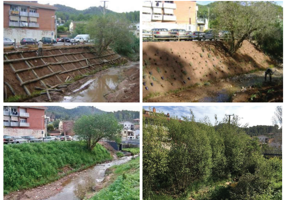
Figura 14 Procés evolutiu d'un enreixat executat per Naturalea
