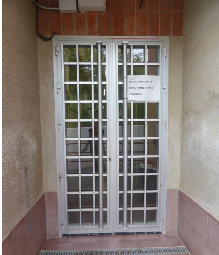
FIG. 1 - PORTA EXTERIOR A INTERVENIR D'ACCÉS A LA ZONA DE L'ASCENSOR
