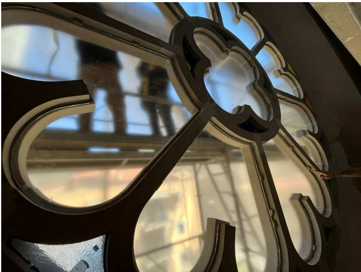
Imatge dels vitralls de la Rosassa, vidre de protecció exterior. Font: Santamaria Arquitectes
