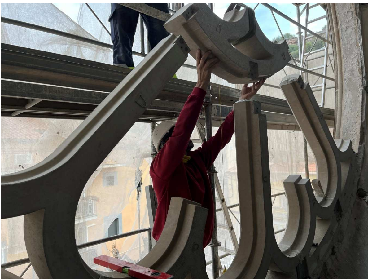
Imatges dels treballs de reconstrucció de la rosassa. Font: Santamaria Arquitectes
