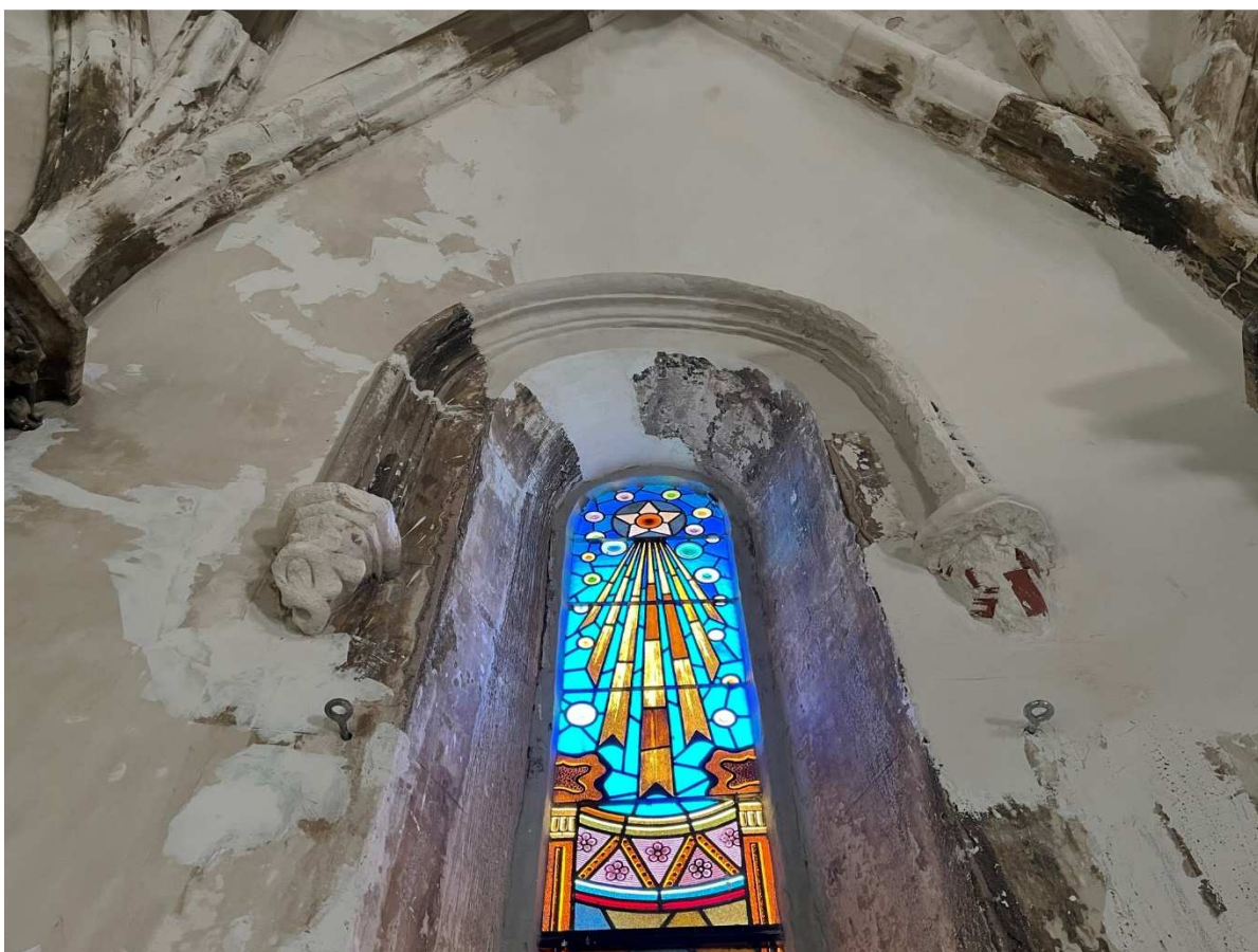
Imatge dels vitralls de l'absis reconstruïts. Font: Santamaria Arquitectes
