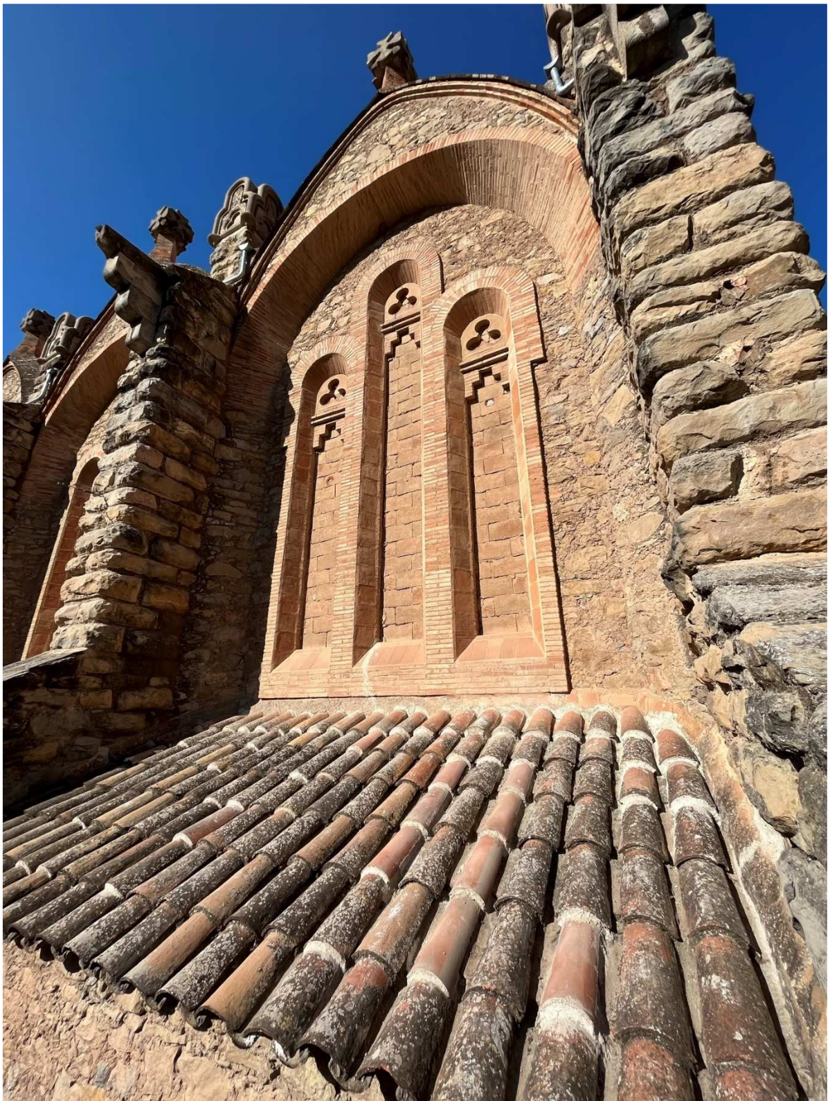
Imatge de les obertures tapiades del nivell superior de la nau central. Font: Santamaria Arquitectes
