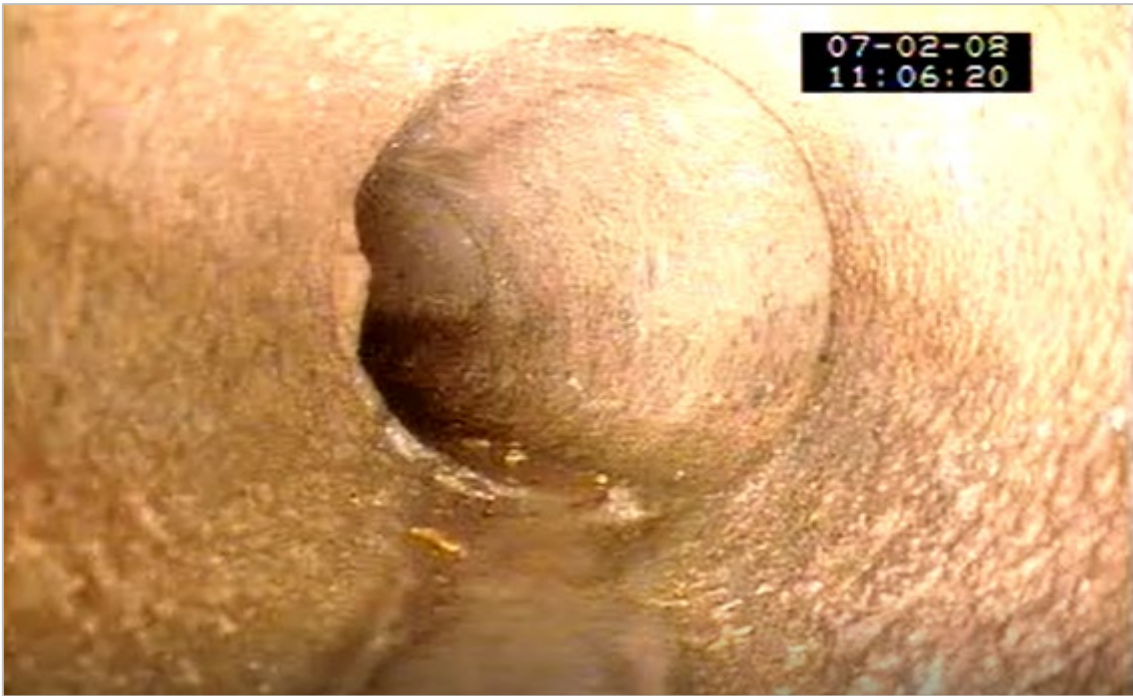
Figura 6. Canvi de direcció del tub sense pou de registre
