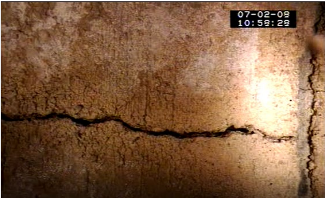
Figura 2. Fissures longitudinals
