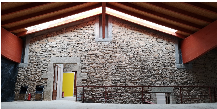
Lluernari en coberta i accés principal a la sala
