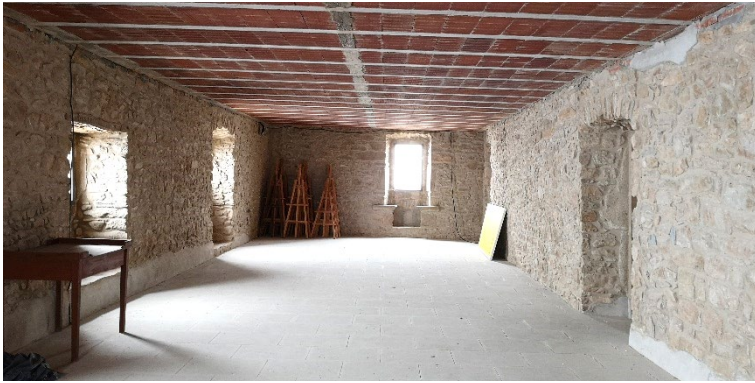
Murs de pedra i forjat de biguetes de formigó i revoltons ceràmics
