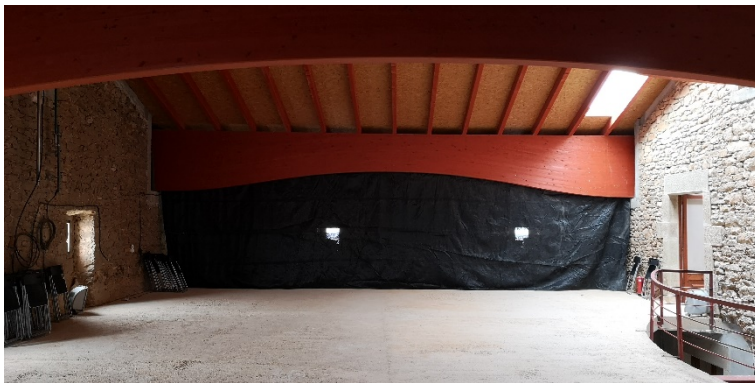
Espai sota coberta amb estructura de fusta vista
