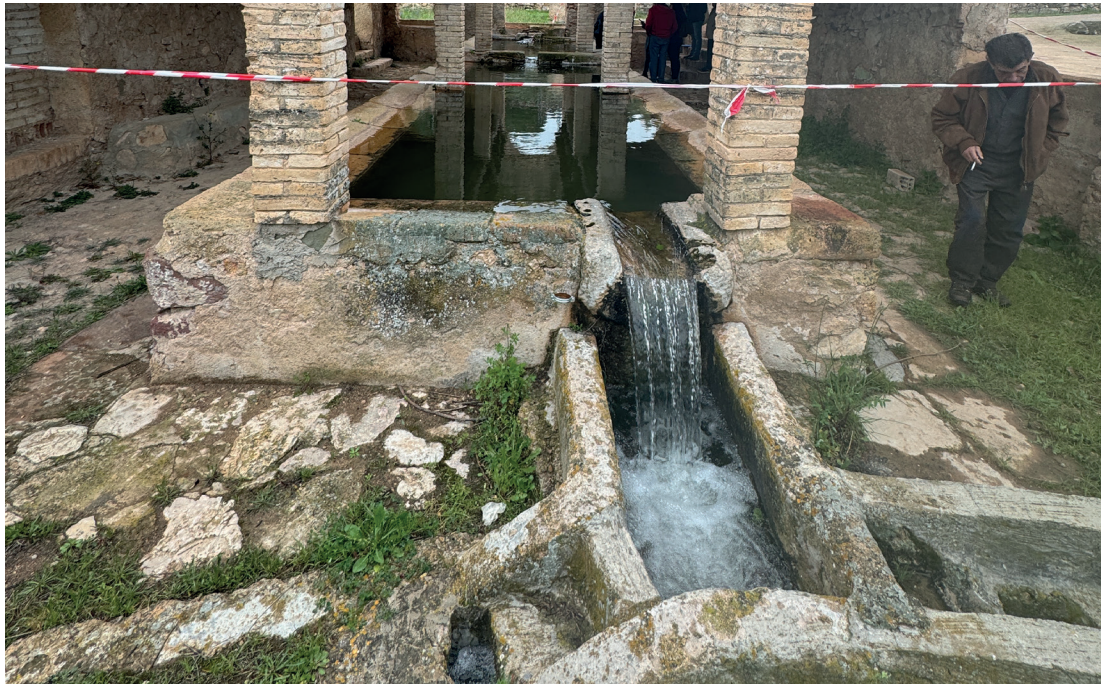
DF.23. Detall caiguda de l'aigua de la bassa cap a la canal de desguàs
