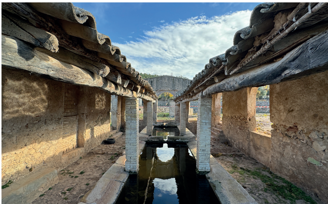
DF.8. Façana est interior
