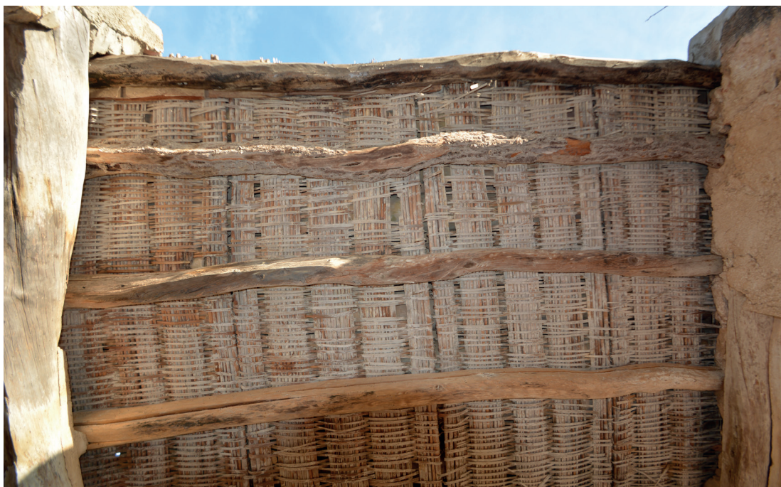
DF.19. Detall del sostre de biguetes de fusta amb entrebigat de canyís
