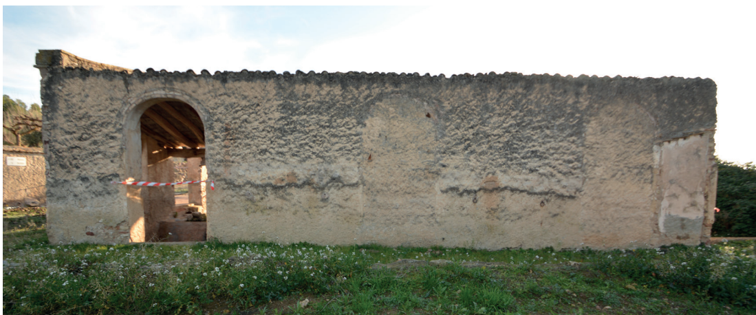
DF.3. Façana nord
