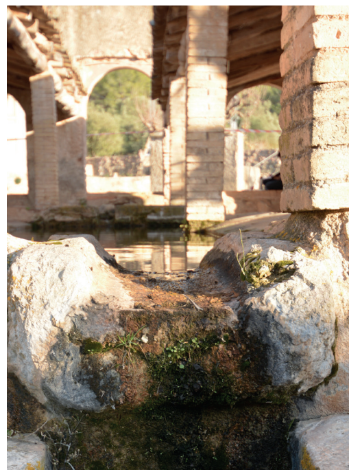
DF.15. Detall de l'evacuació de l'aigua de la bassa
