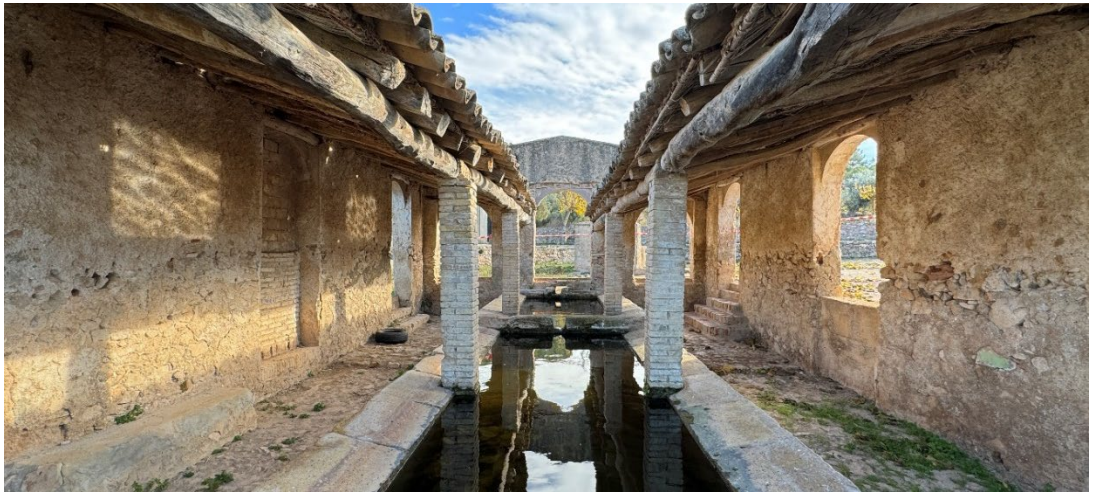
DF3 Vista interior amb detall de la façana principal orientada a l'est
