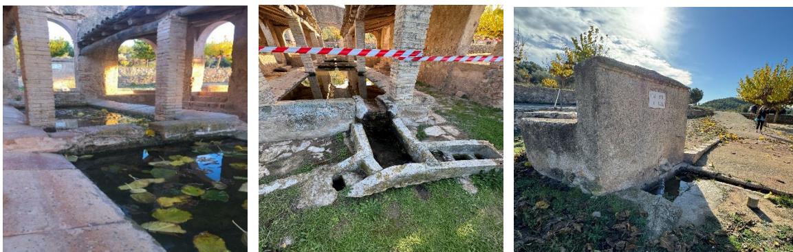
DF6 Vista bassa d'aigua i el seu sistema de desguàs
