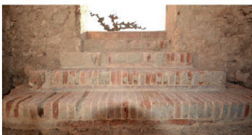
DF.10. Escala situada a l'accés sud
