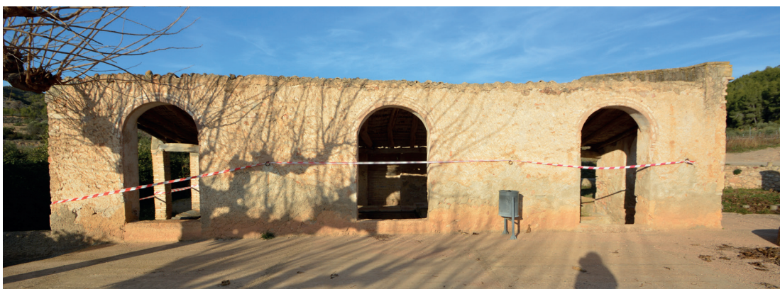
DF.4. Façana sud
