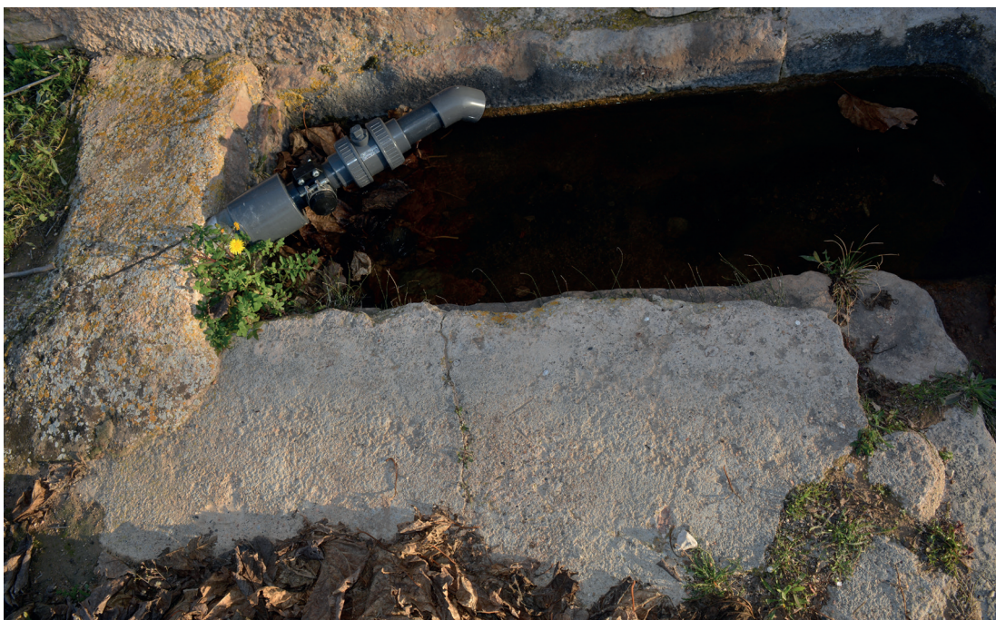
DF.19. Detall de l'actual sistema de subministrament d'aigua a la bassa
