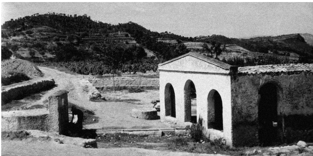
DFH1 Vista de la font, el pou i els rentadors on es pot observar el canvi de nivell del terra amb la consegüent exposició de les pedres de la canal.
