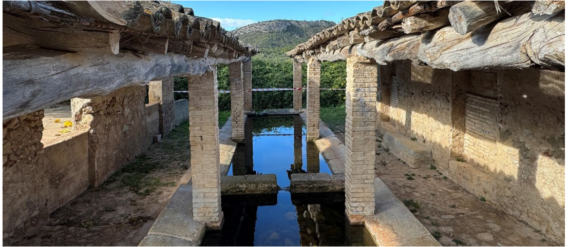
DF2 Vista interior amb detall de la façana oberta orientada a l'oest
