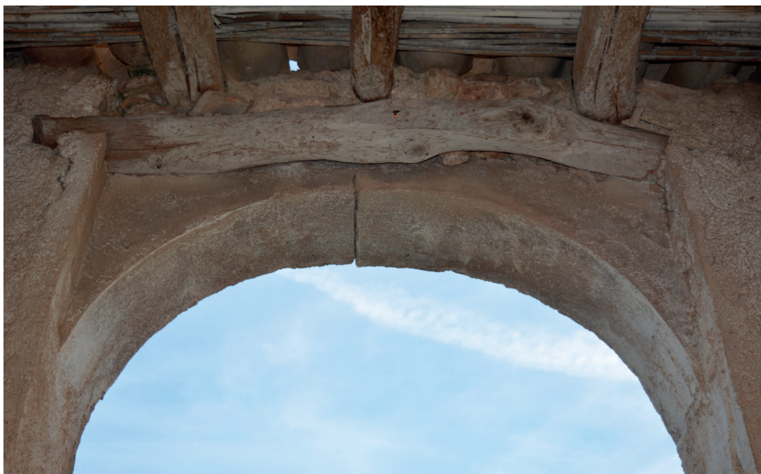
DF.21. Detall trobada de la coberta amb l'arc
