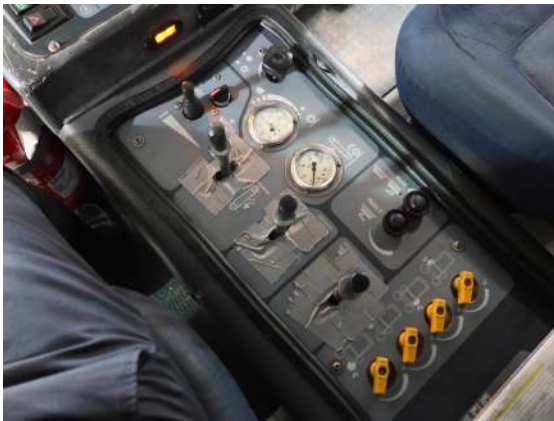
cuadro de mando deteriorado por uso
