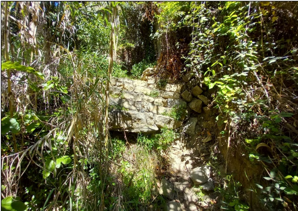
Figura 7. Mur col·lapsat
