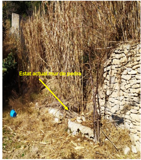
Figura 7. Estat actual del mur delimitador del camí
