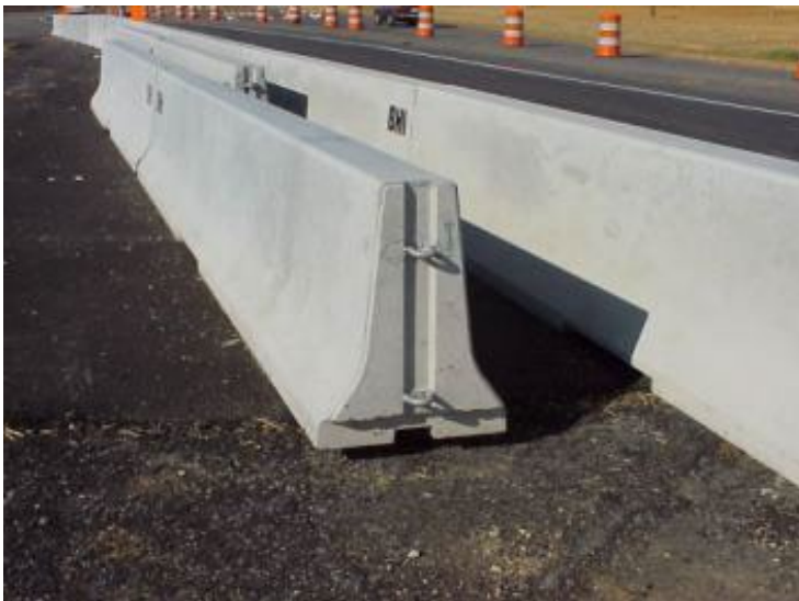
Barrera de formigó tipus New Jersey per separació trànsit rodat
