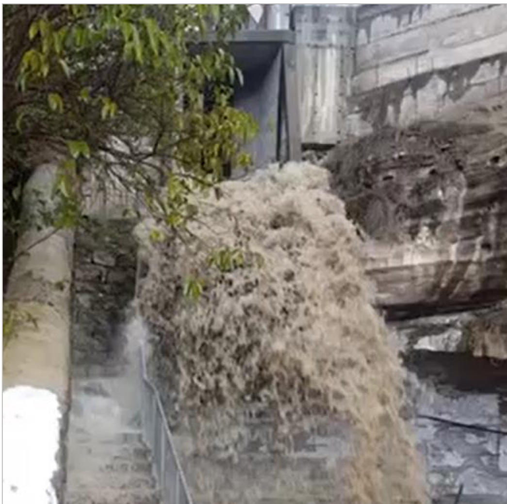
Figura 5. Sortida del calaix del Torrent de la Creu del Tort abocant aigua
