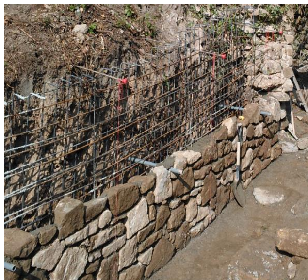
Figura 11. Exemple de tipologia de mur a realitzar
