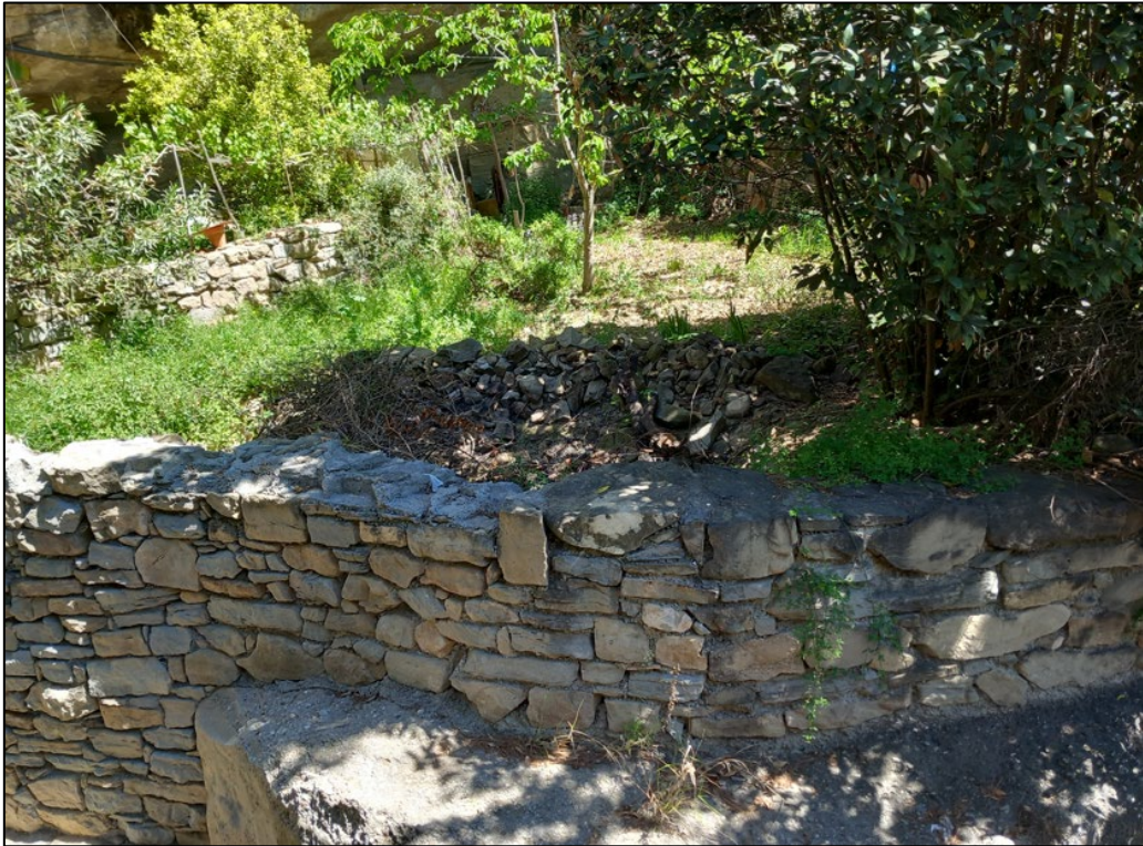
Figura 2. Parcel·la on es preveu executar la cuneta per evacuar les aigües procedents del calaix
