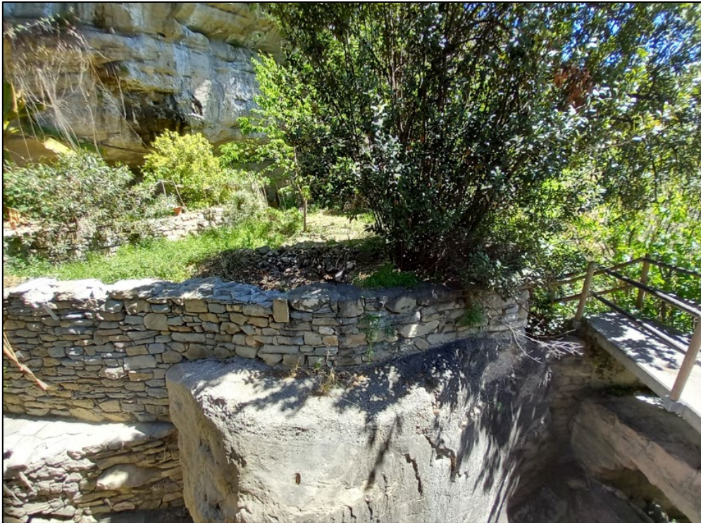
Figura 4. Parcel·la on es preveu executar la cuneta per evacuar les aigües procedents del calaix
