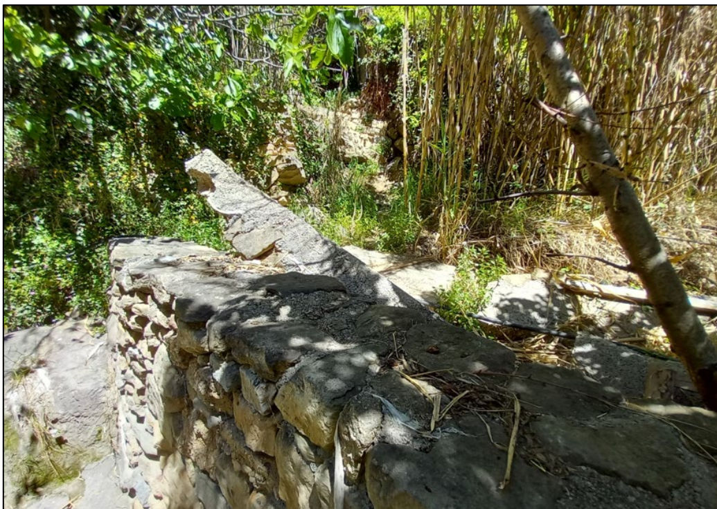
Figura 9. Mur col·lapsat
