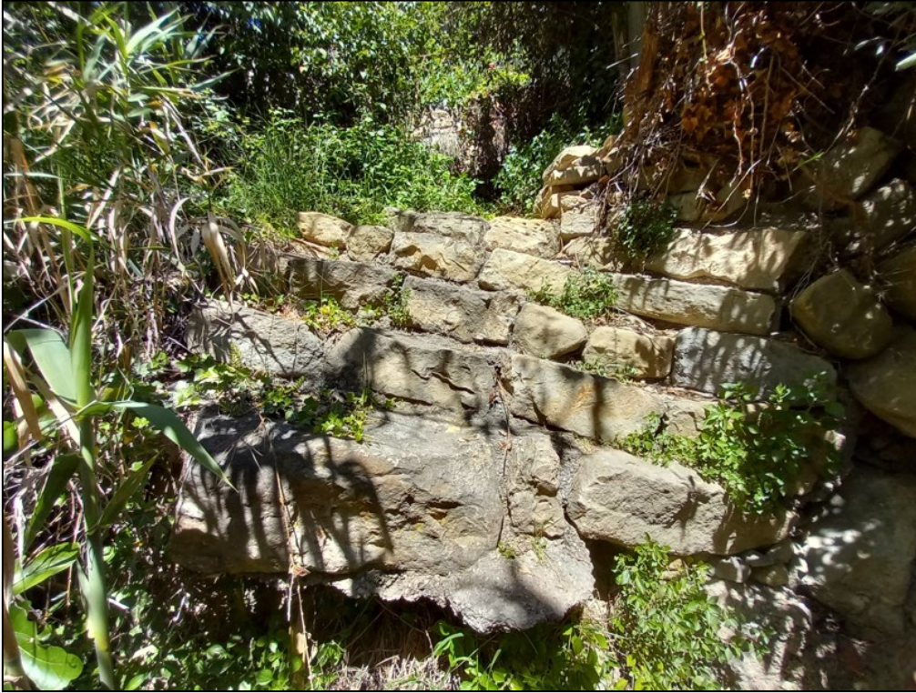
Figura 6. Mur col·lapsat
