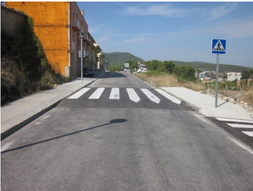
Pas de vianants elevat
