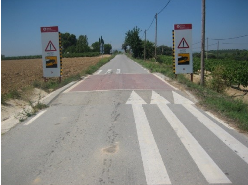
Plataforma reductora de velocitat en secció
