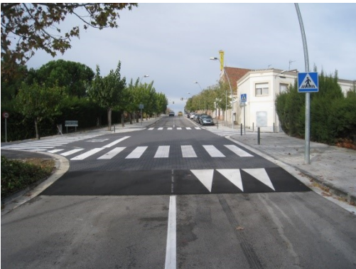
Plataforma reductora de velocitat en cruïlla
