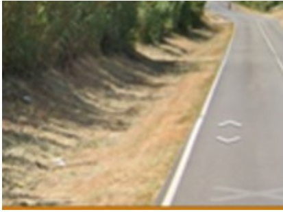
Cuneta no revestida
