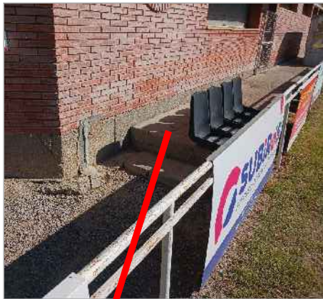
ENDERROC DE PAVIMENT
