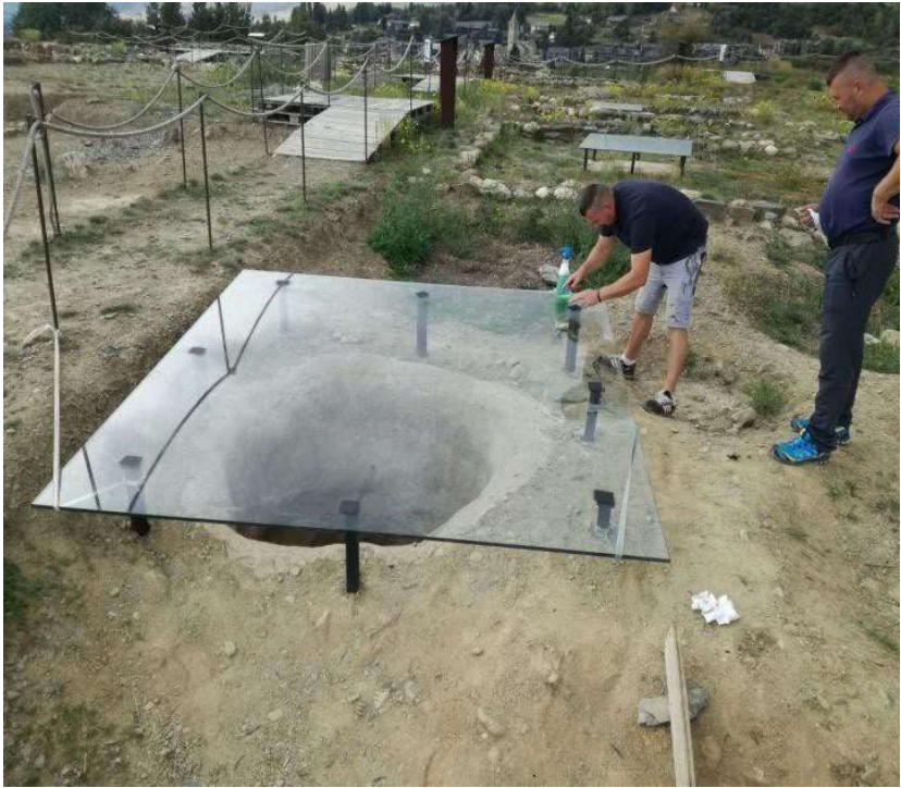
Fig 32: Sitja ja consolidada, i col·locació del vidre protector
