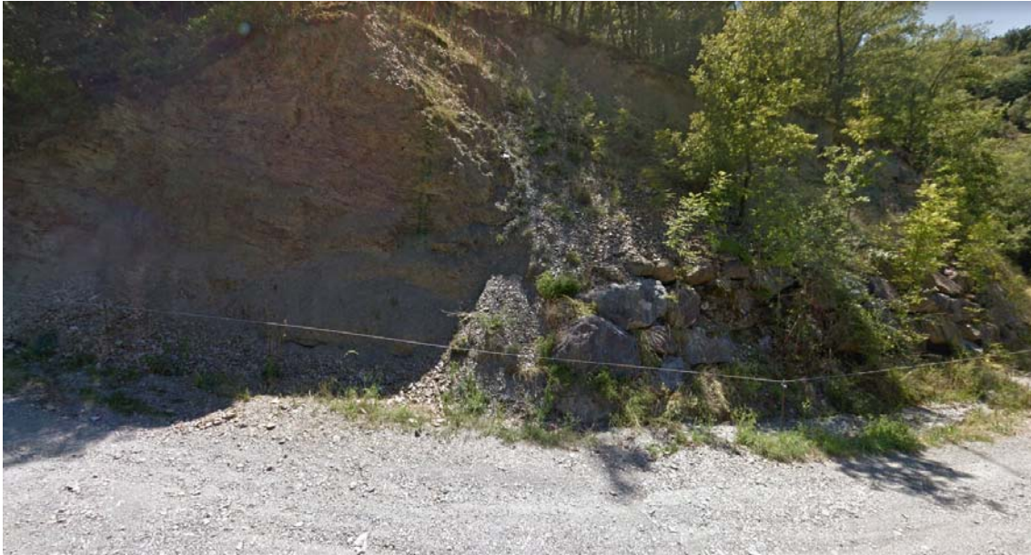
Tram inicial del camí on cal reperfilar talús, fer cuneta i petita escollera.
