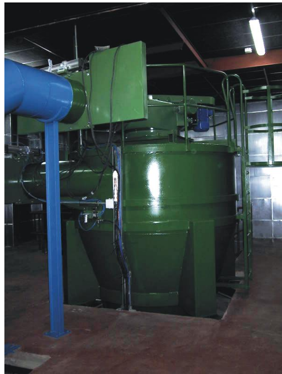
Vàlvula de seccionamiento.
