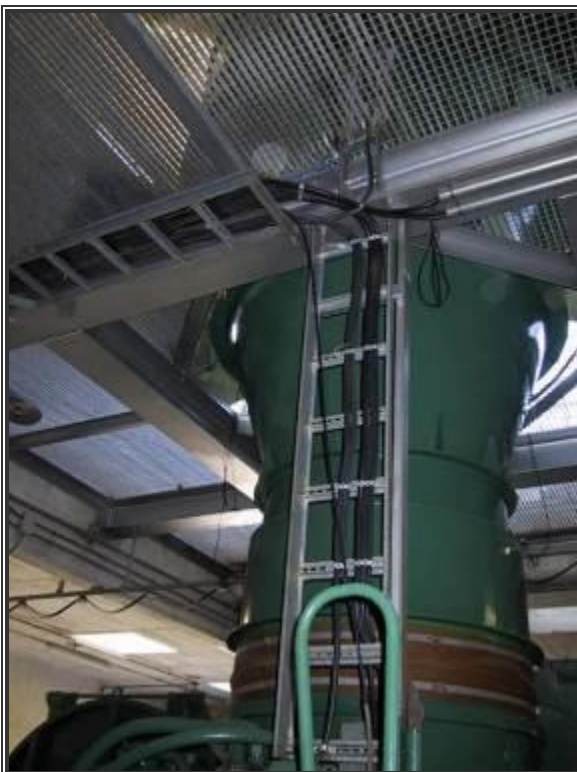
Acoplamiento compactador de residuos-ciclón de recogida
