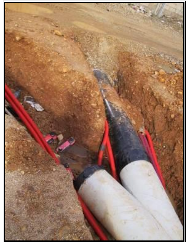
Ramal. Tendido de conduits.
