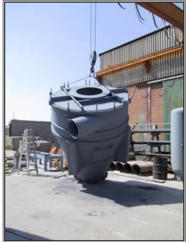
Montaje de ciclón de recogida
