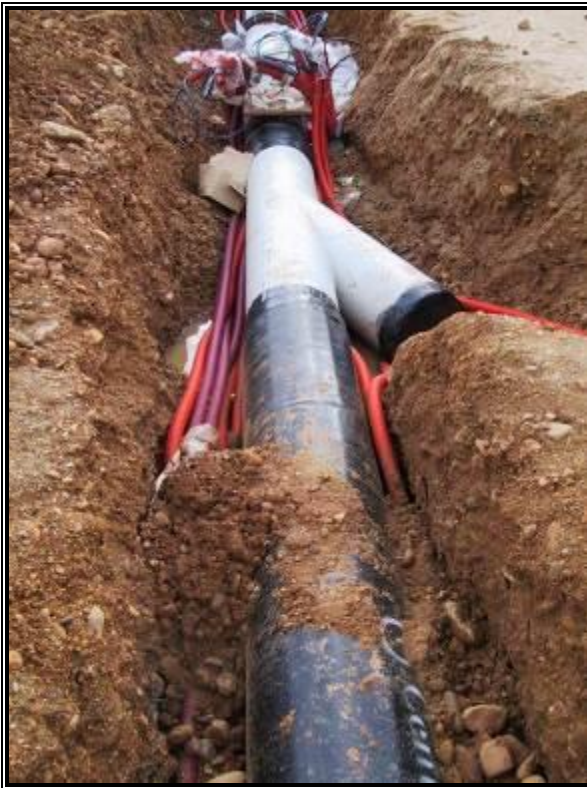
Montaje en obra. Tendido de conduits.
