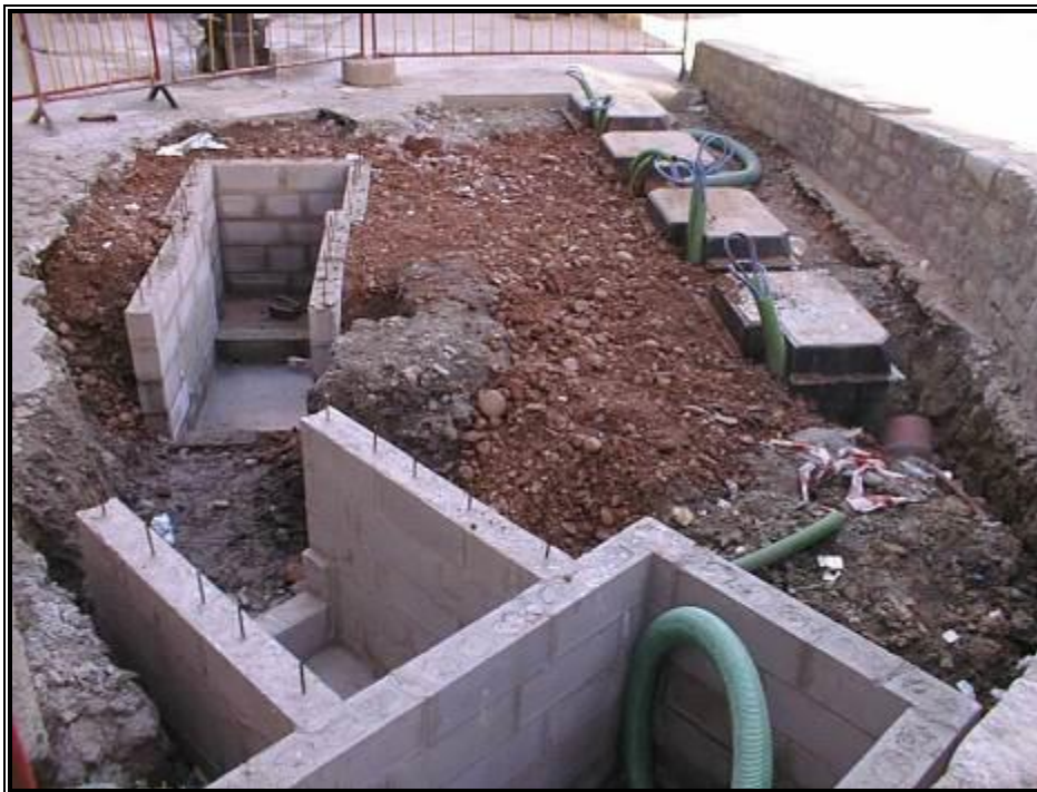
Arqueta doble en ejecución. Propuesta en proyecto.
