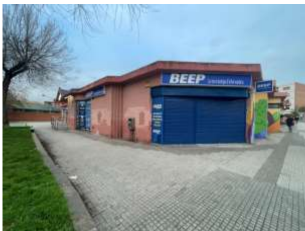
Elements de façana a desmuntar.
