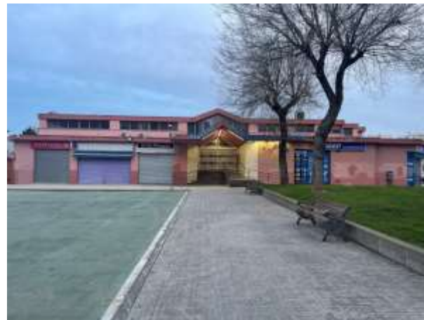
Façana lateral esquerra.
