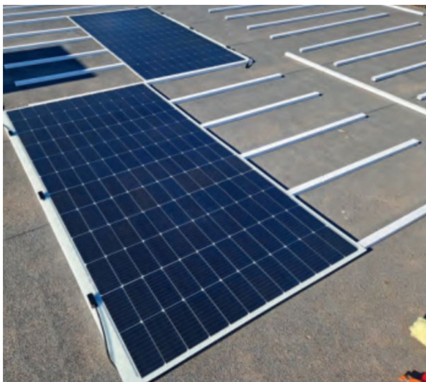
Fig. 5.3. Muntatge de mòdul fotovoltaic flexible mitjançant perfil PVC i adhesiu 380 FOIL BAND.
