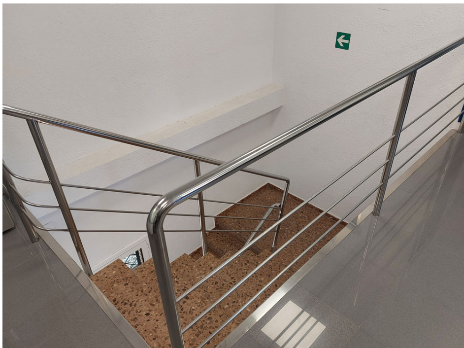
Edifici laboratoris vell
