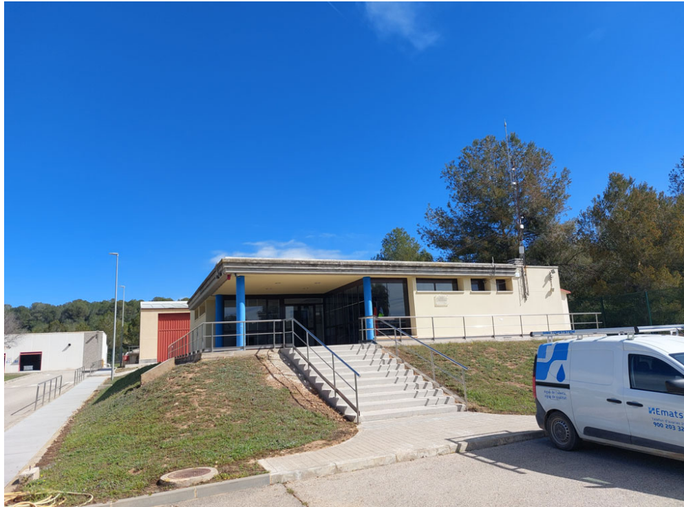
Edifici d'oficines i vestuari
