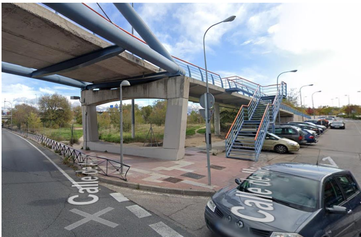
Figura 23. Exemple de Pila Pont de Madrid.
