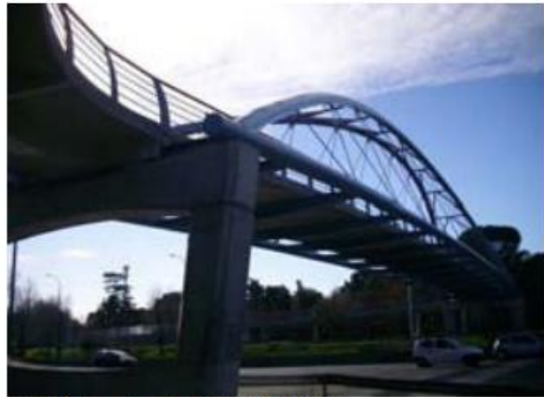
Fig.16 Pasarela sobre la N-VI. Vista inferior
