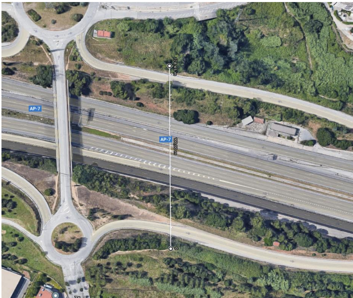
Figura 11. Longitud tota del pont en cas de piles situades fora dels ramals.
