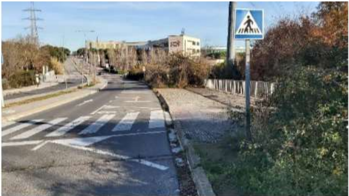
Figura 48. Pont sobre Torrent d'en Gornal.
