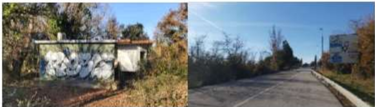
Figura 7. Edificacions i Ramal de Sortida B-30
