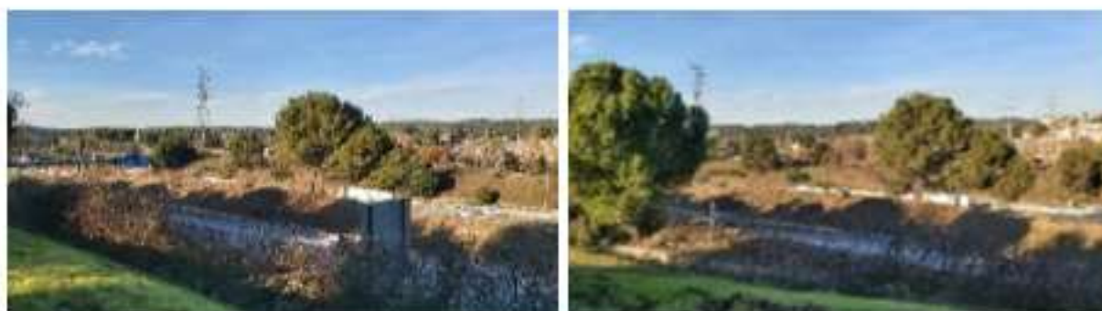
Figura 22. Imatges Emplaçament Pont
