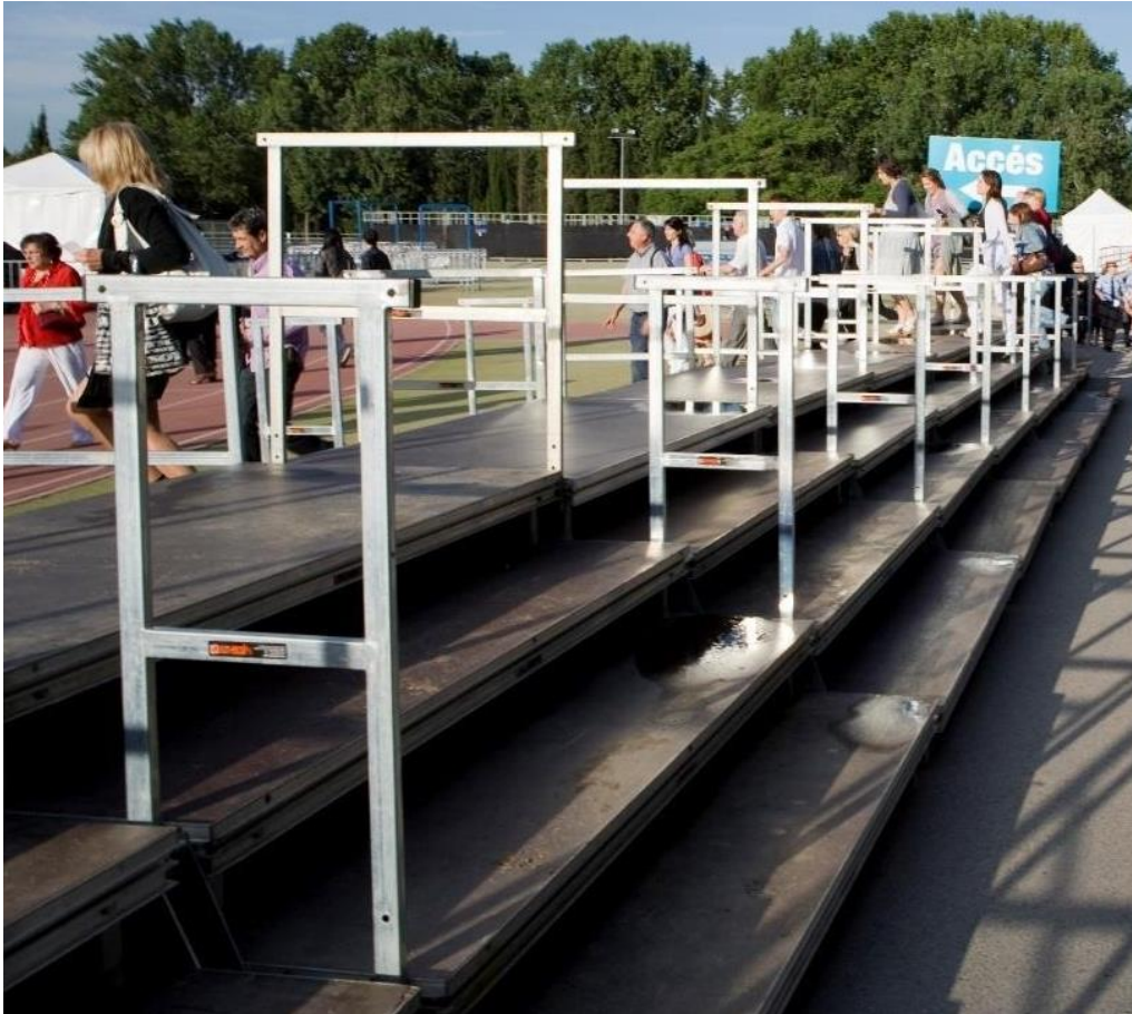
Foto 5: Escaleres d'accés a la explanada de la pista d'atletisme. Estructura formant graons de pujada i baixada, per salvar un muret de formigó que limita el camp, i facilitar l'entrada del públic.
