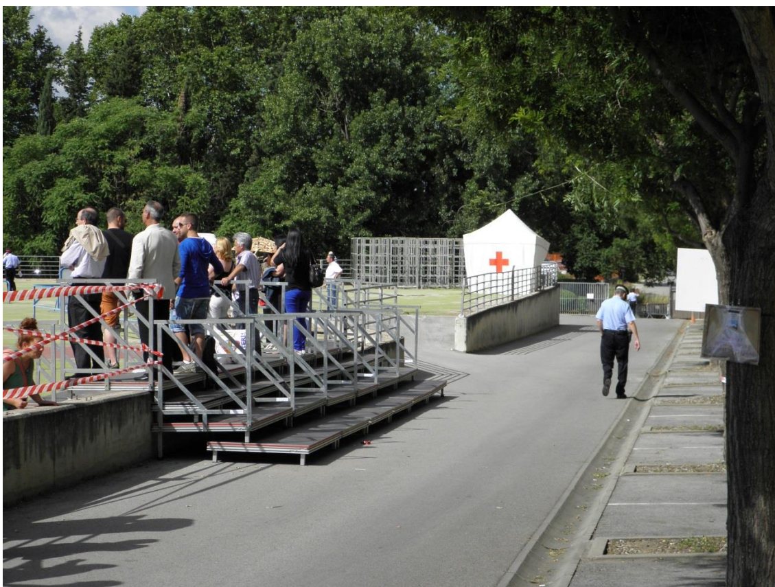
Foto 4: Escales d'accés a la explanada de la pista d'atletisme. Estructura formant graons de pujada i baixada, per salvar un muret de formigó que limita el camp, i facilitar l'entrada del públic.
