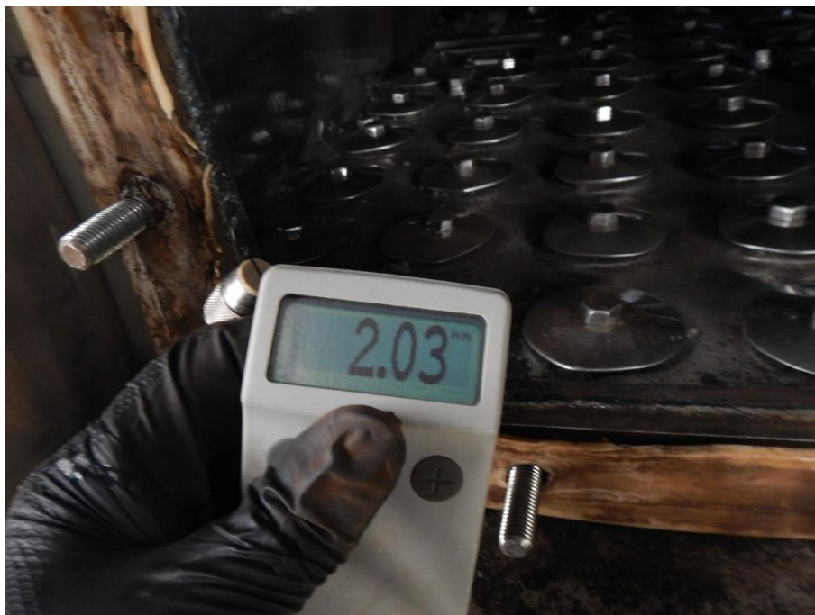
Medida de espesor del codo de los tubos del intercambiador
