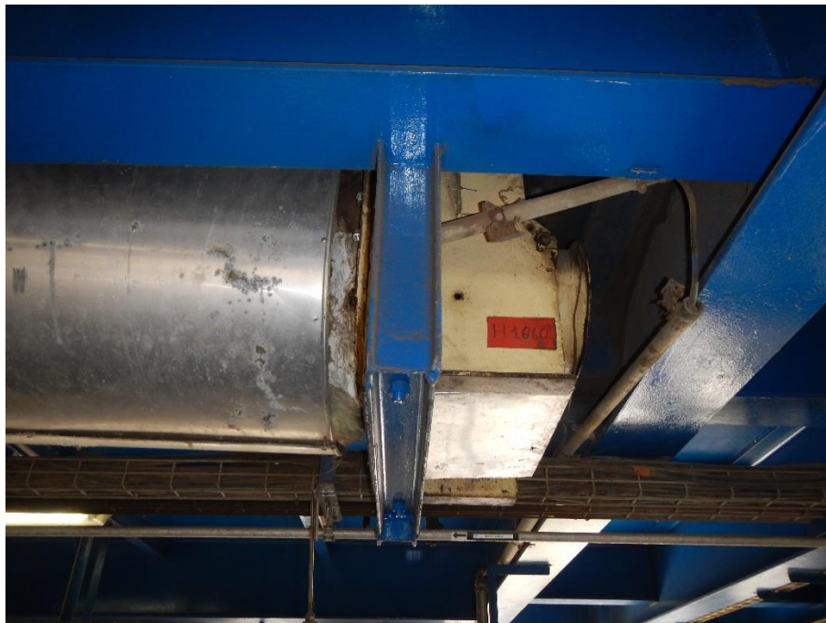
Transportador sinfín , reparación interior del canal
