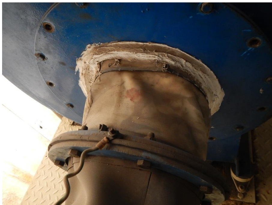
Ventilador de aspiración V0460, reparación
