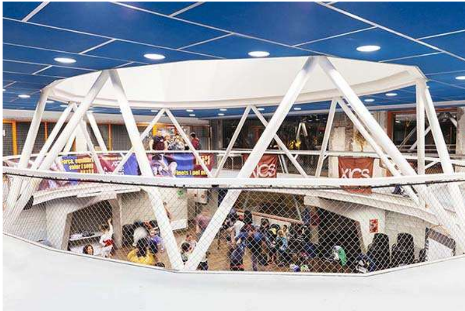
Vista gelosia d'acer laminat existent
