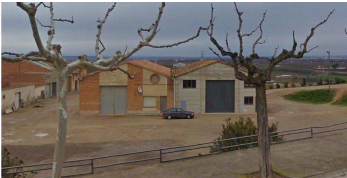
Figura 3. Imagen de la entrada de suministro eléctrico al almacén.
