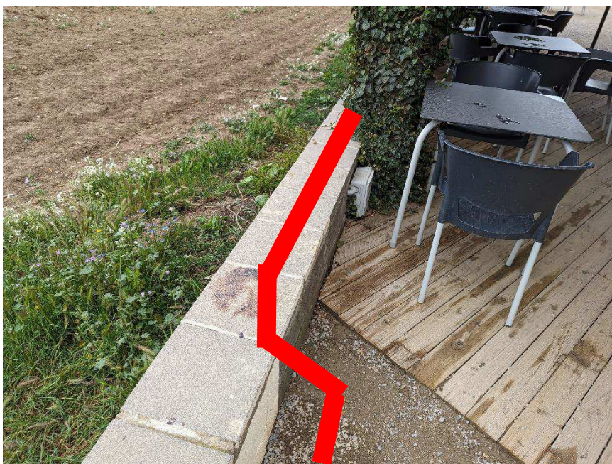
Proposta traçat integració xarxa i compatibilitat amb tarima preexistent. Transició enterrat-encastat inicial
