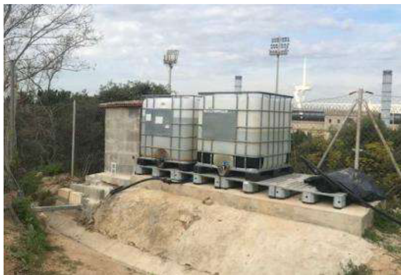
Imatge de la instal·lació actual d'emmagatzematge d'aigua.
