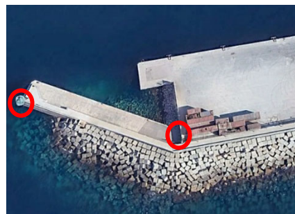
Zona d'accés i actuació de l'obra
