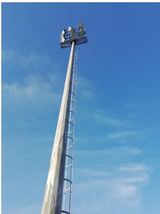
Torre d'il·luminació amb 12 projectors
