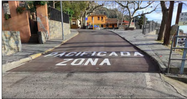
Imatge 1. Accés al nucli del Montseny un cop executada la primera fase.
