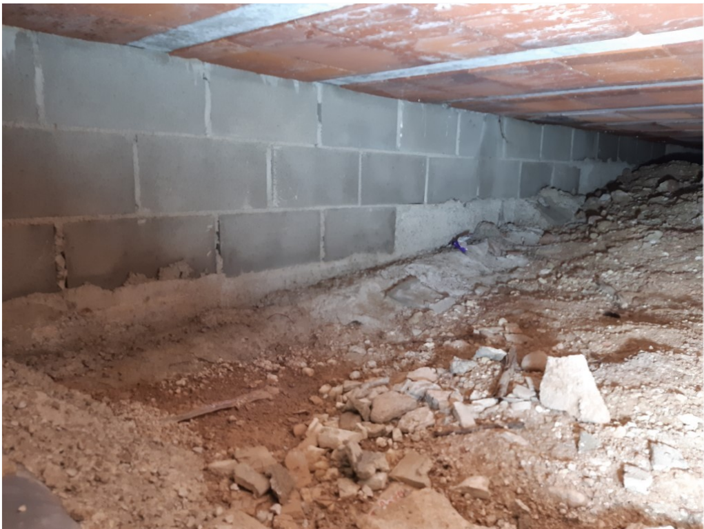
04 - VISTA INFERIOR DE FORJAT
