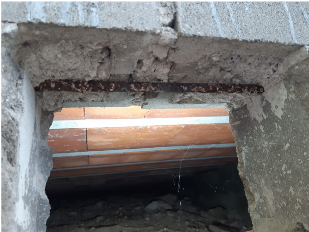
05 - ARMAT LONGITUDINAL DE BLOC DE FORMIGÓ
