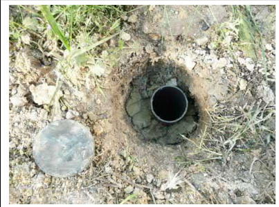
Foto 7: Detall piezòmetre instal·lat a sondeig S-2.
