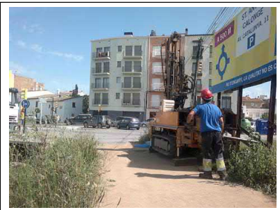
Foto 3: Sonda RL-48c al sondeig S-2 (TA-MG-10011).
