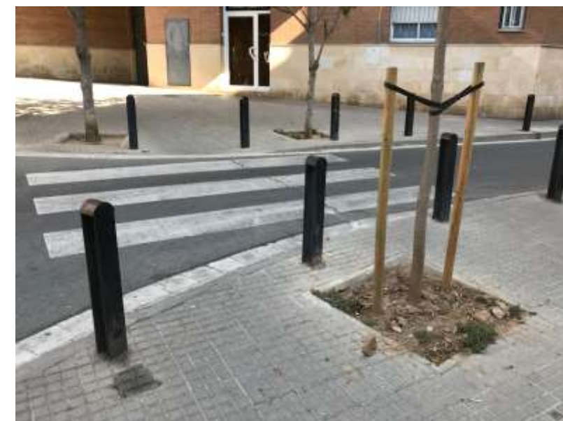
Foto 6: Escocells a cobrir amb paviment articulat
