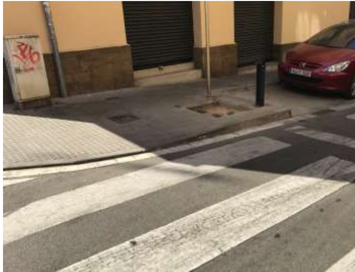
Foto 8: Escocell a cobrir amb paviment de panot
