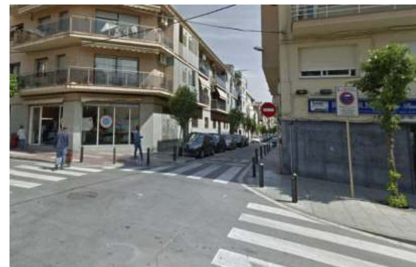
Foto 17: Cantonada nord amb paviment vermell i est amb llosa formigó
