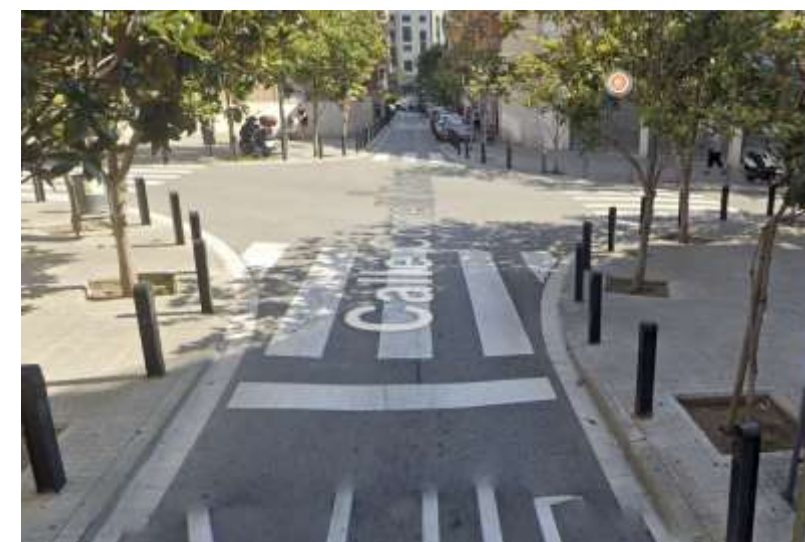
Foto 7: Escocells a cobrir amb paviment articulat
