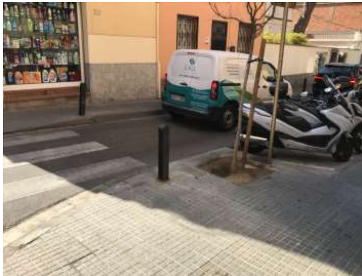
Foto 9: Escocell per cobrir amb paviment articulat
